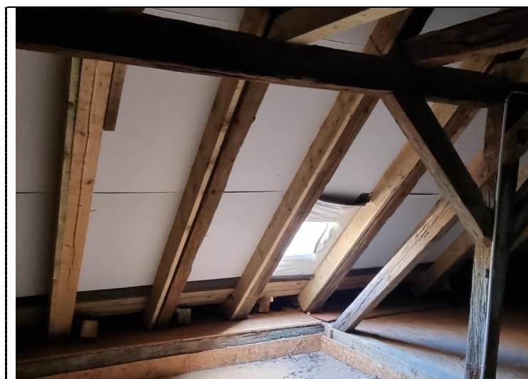
Obr. 6 Zesílené krokve krovu uliční části [P1]
