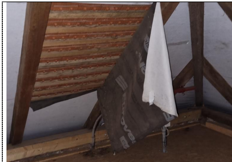
Obr. 13 Porušená pojistná hydroizolace u krátké valby [P1]
