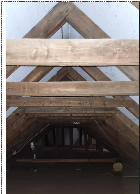
Obr. 10 Hambalkový krov dvorní části [P1]
