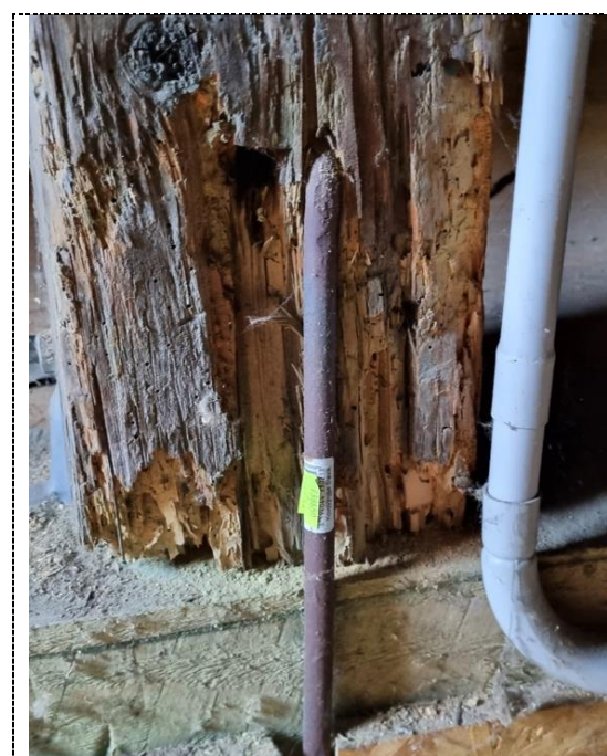
Obr. 5 Pata sloupů krovu uliční části napadená biotickými škůdci [P1]
