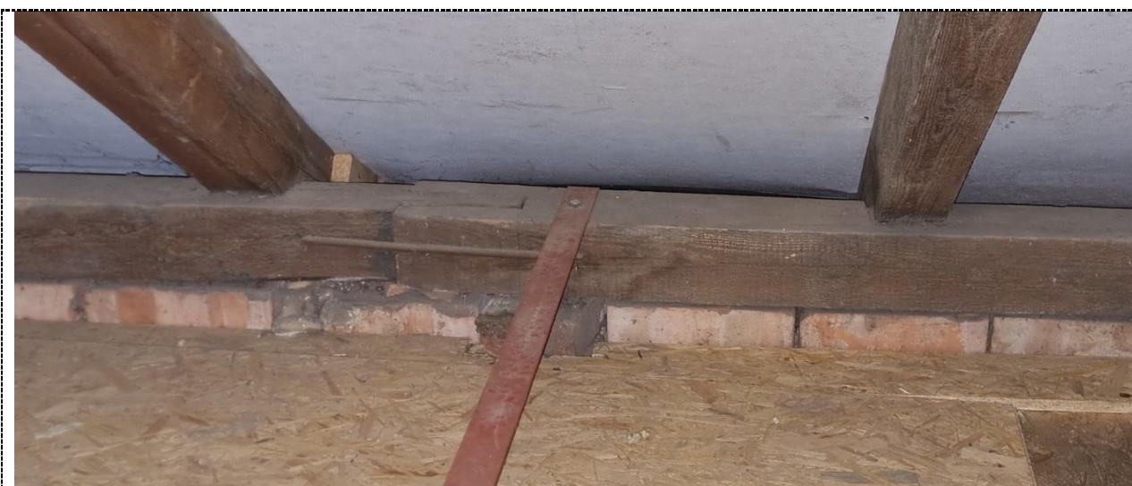
Obr. 11 Spoj hambalku a krokví [P1]
