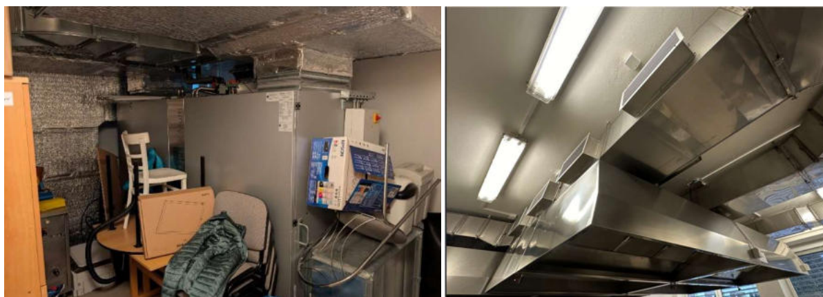
Obrázek 62 – VZT jednotka pro kuchyň
