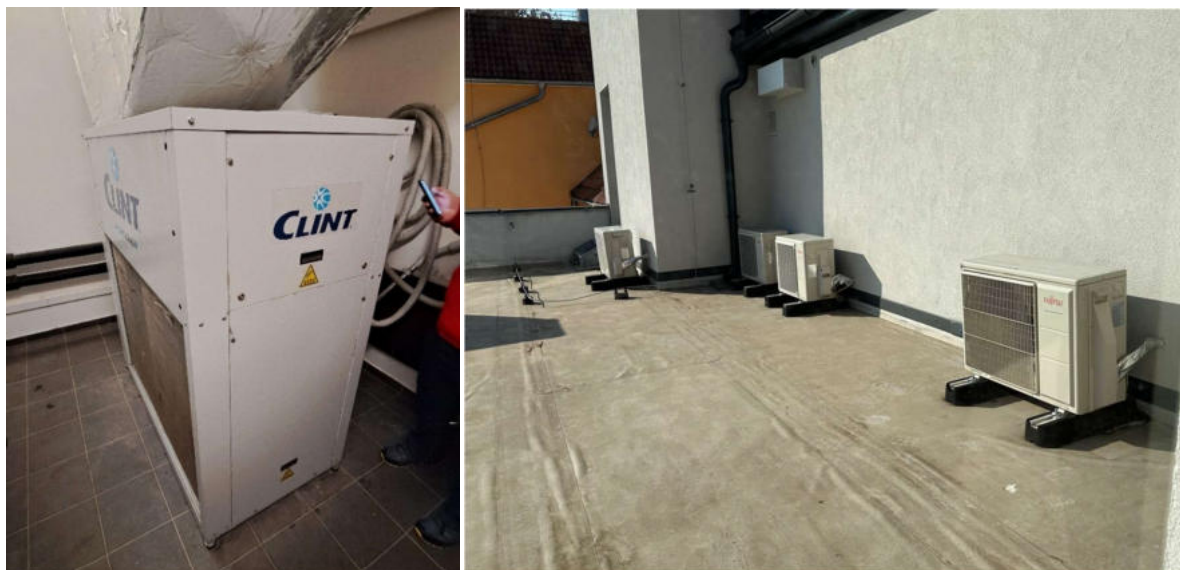
Obrázek 85 – VRF jednotka, split jednotky
