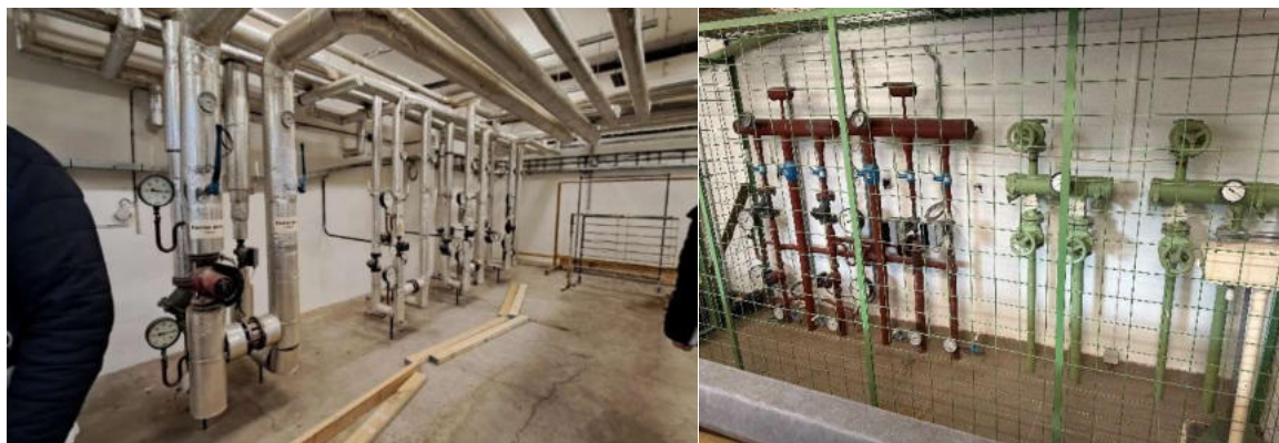
Obrázek 33 – hlavní a podružný R/S
