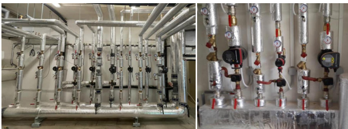
Obr. 2.2.2.: topné větve po rekonstrukci
