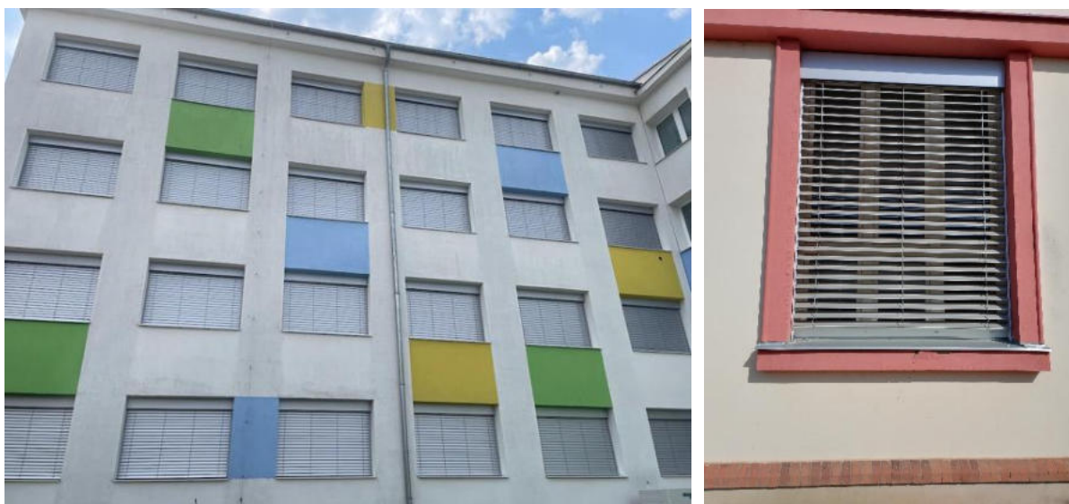
Obr. 2.3.3.: instalace stínící techniky
