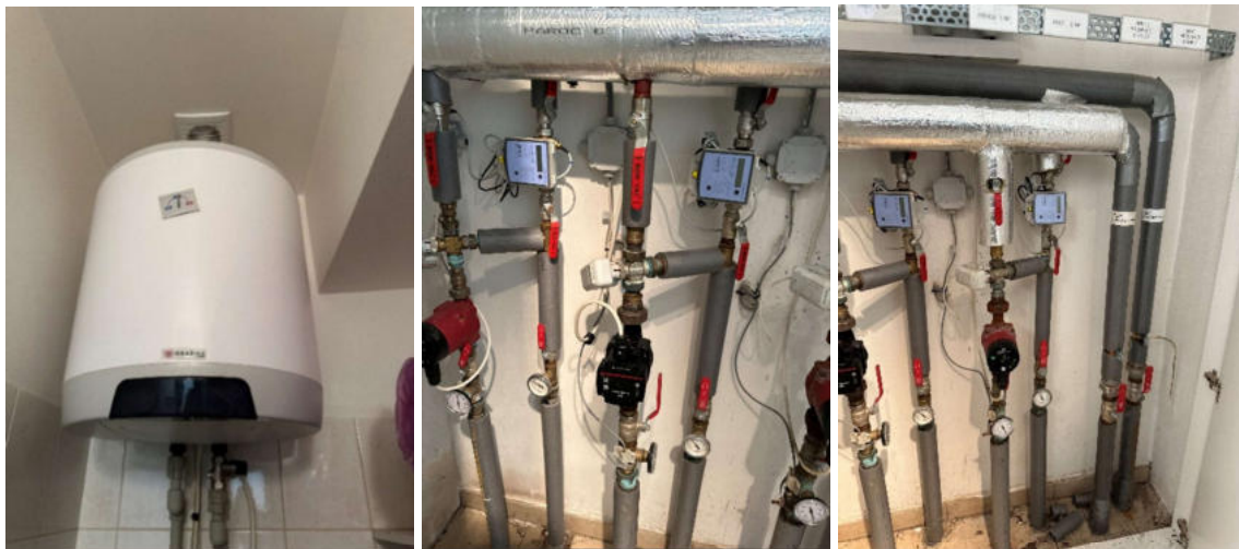
Obrázek 78 – Zásobníkový ohřivač, R/S
