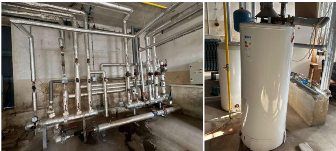
Obrázek 66 – Hlavní R/S, ohřev TUV
