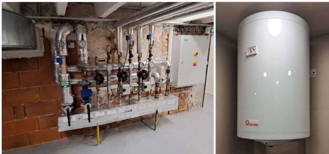
Obrázek 82 – Hlavní R/S, ohřev TUV
