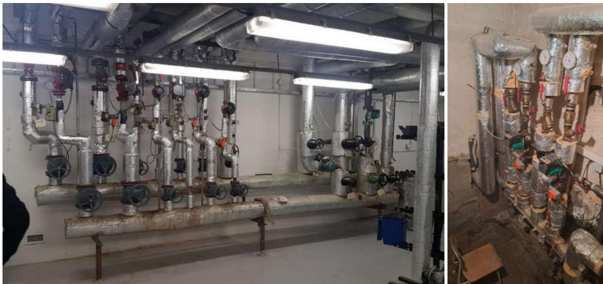
Obrázek 28 – hlavní R/S a podružný R/S
