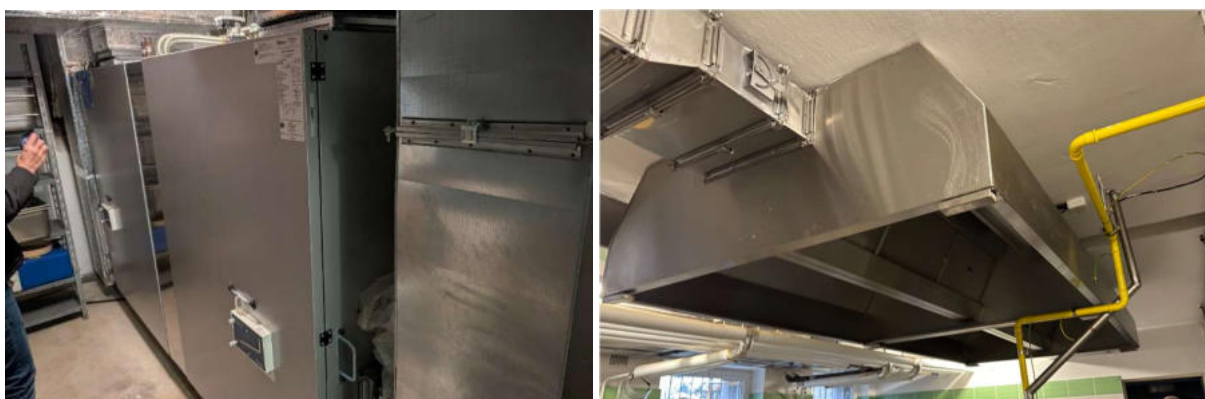
Obrázek 52 – VZT jednotka pro kuchyň
