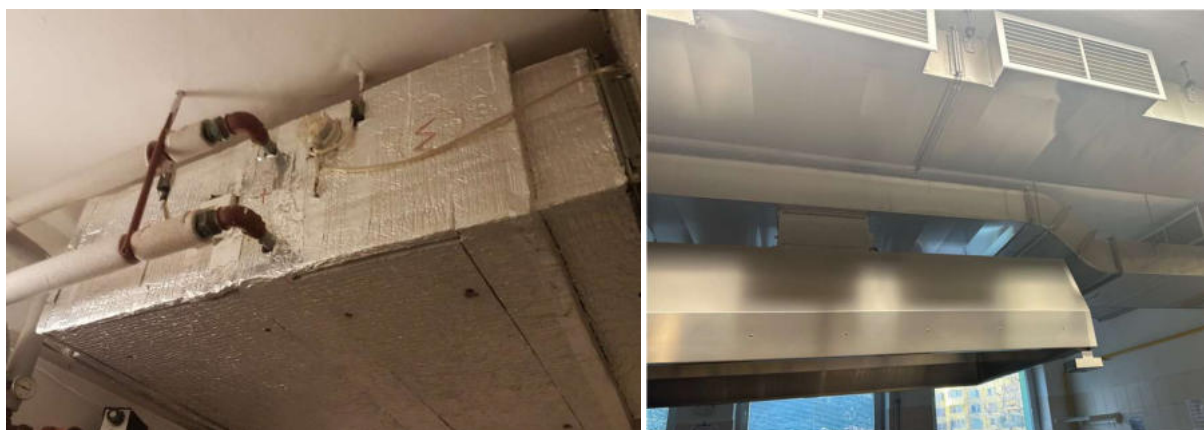
Obrázek 57 – VZT jednotka pro kuchyň
