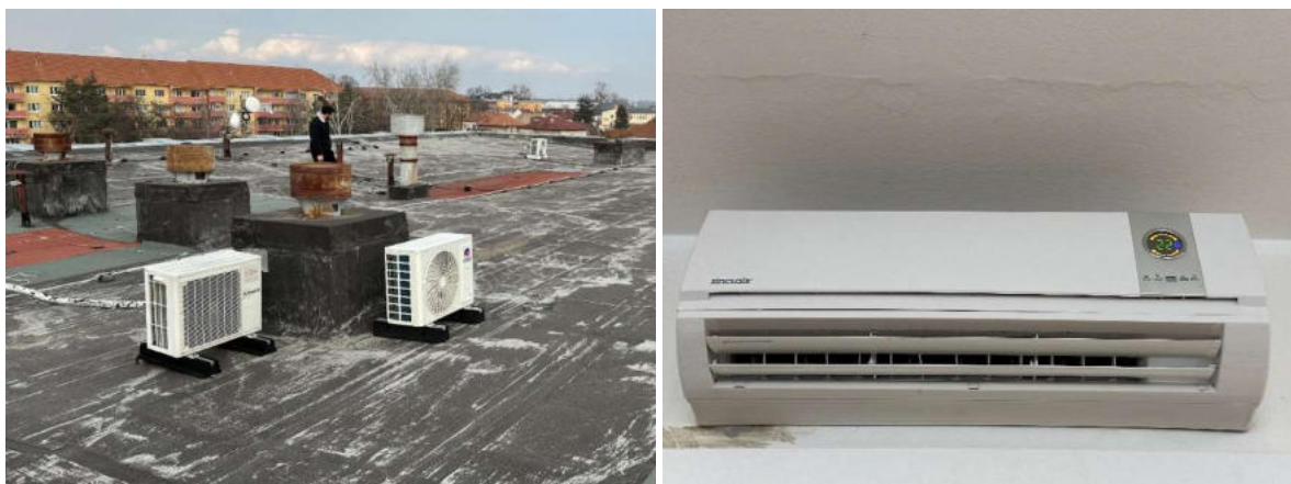
Obrázek 109 – Split jednotky, vnitřní jednotka
