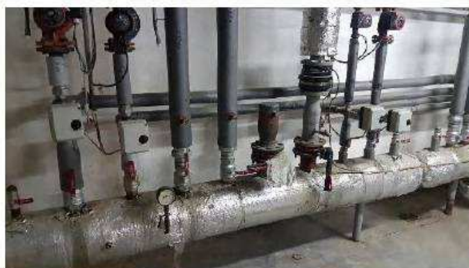
Stávající R/S – hlavní budova
