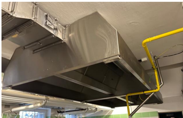
Obrázek 52 – VZT jednotka pro kuchyň
