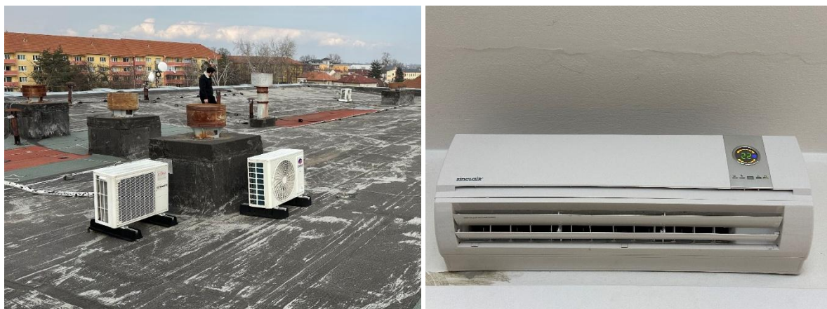
Obrázek 109 – Split jednotky, vnitřní jednotka
