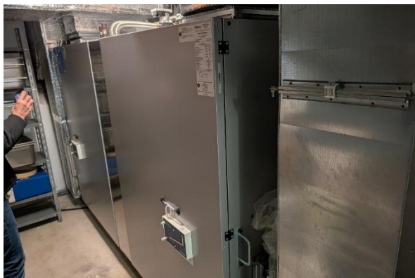
Obrázek 52 – VZT jednotka pro kuchyň
