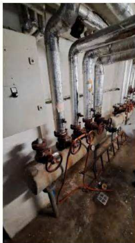
Stávající R/S – hlavní budova
