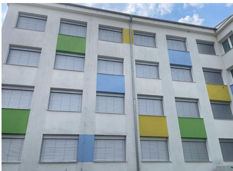
Obr. 2.3.3.: instalace stínicí techniky
