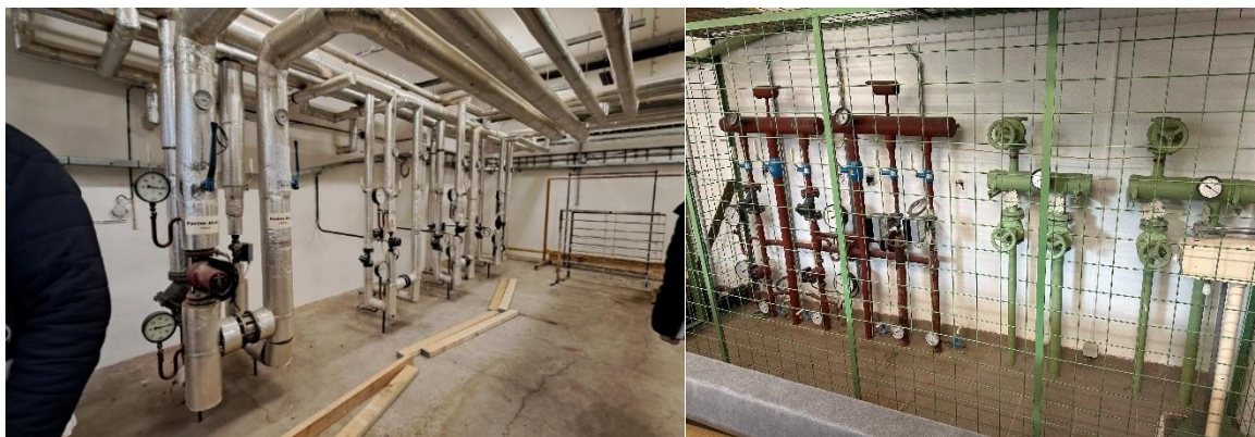
Obrázek 33 – hlavní a podružný R/S
