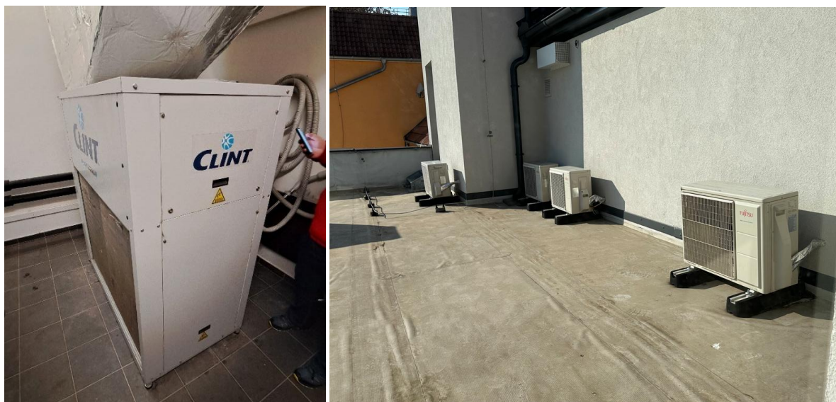
Obrázek 85 – VRF jednotka, split jednotky
