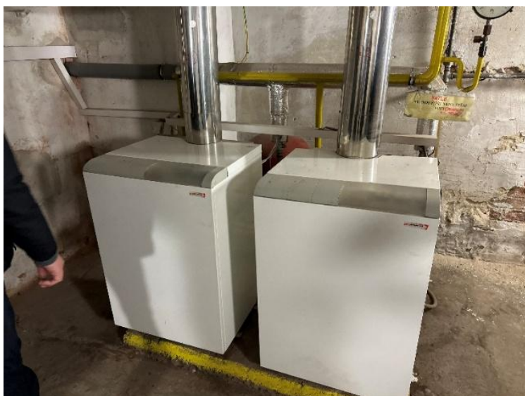
Obrázek 93 – Plynové kotle, ohřev TUV
