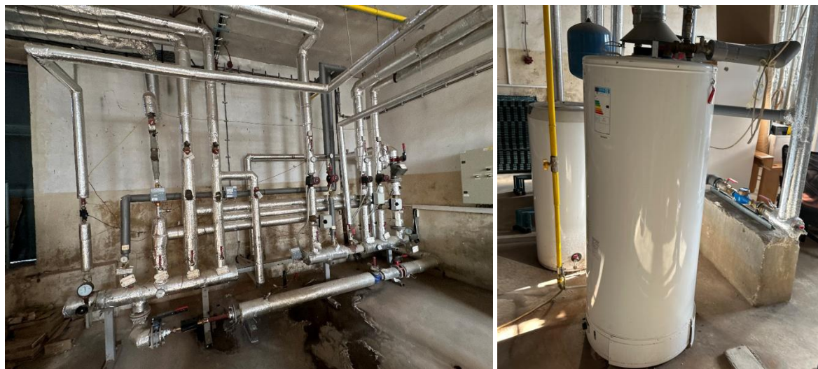
Obrázek 66 – Hlavní R/S, ohřev TUV
