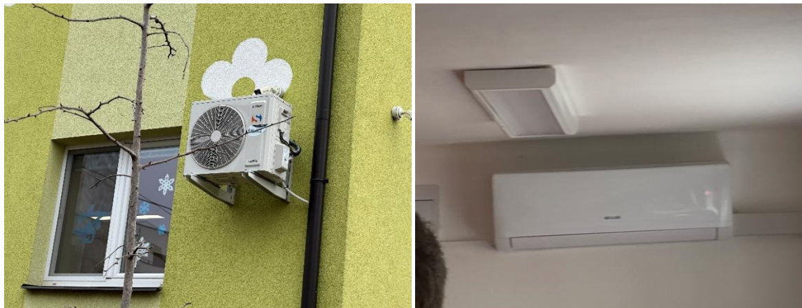
Obrázek 99 – Split jednotka, vnitřní jednotky
