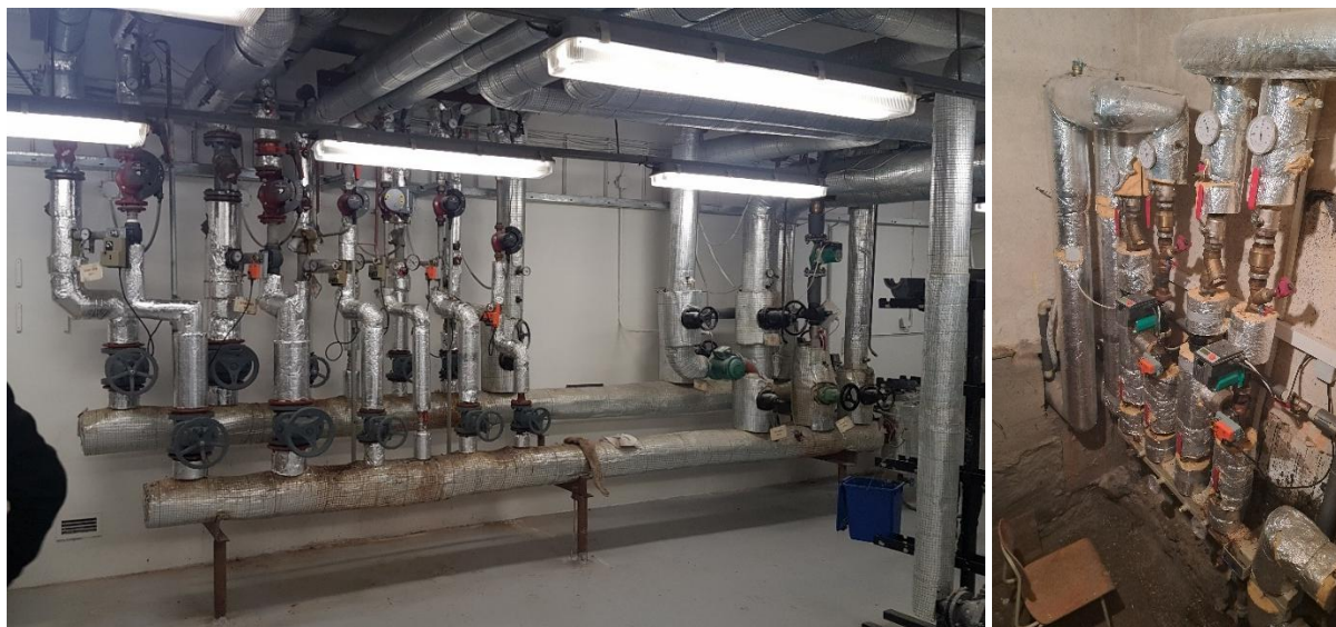
Obrázek 28 – hlavní R/S a podružný R/S
