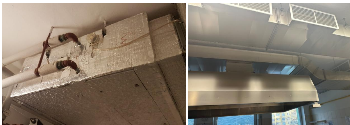
Obrázek 57 – VZT jednotka pro kuchyň
