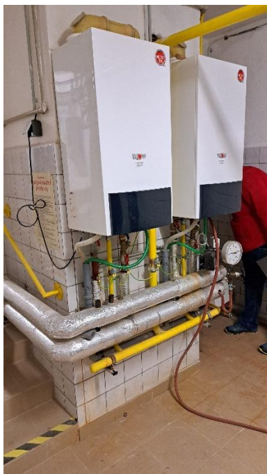
Obrázek 72 – Plynové kotle
