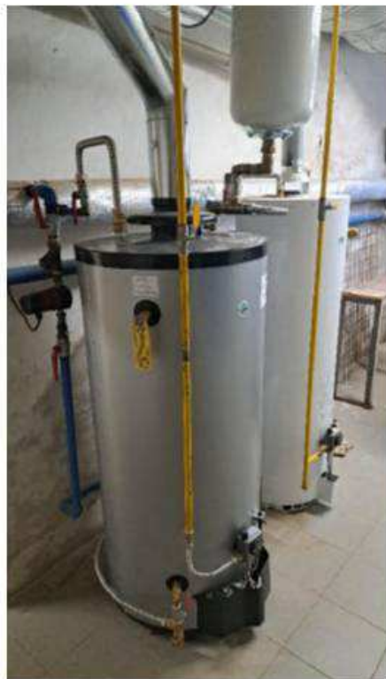
Ohřev TUV – 2x plynový zásobníkový ohřivač
