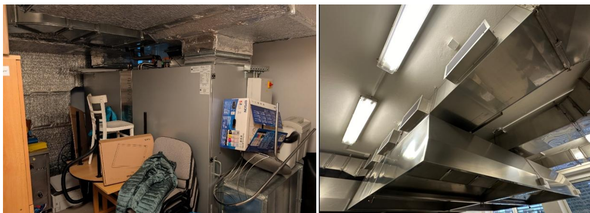
Obrázek 62 – VZT jednotka pro kuchyň
