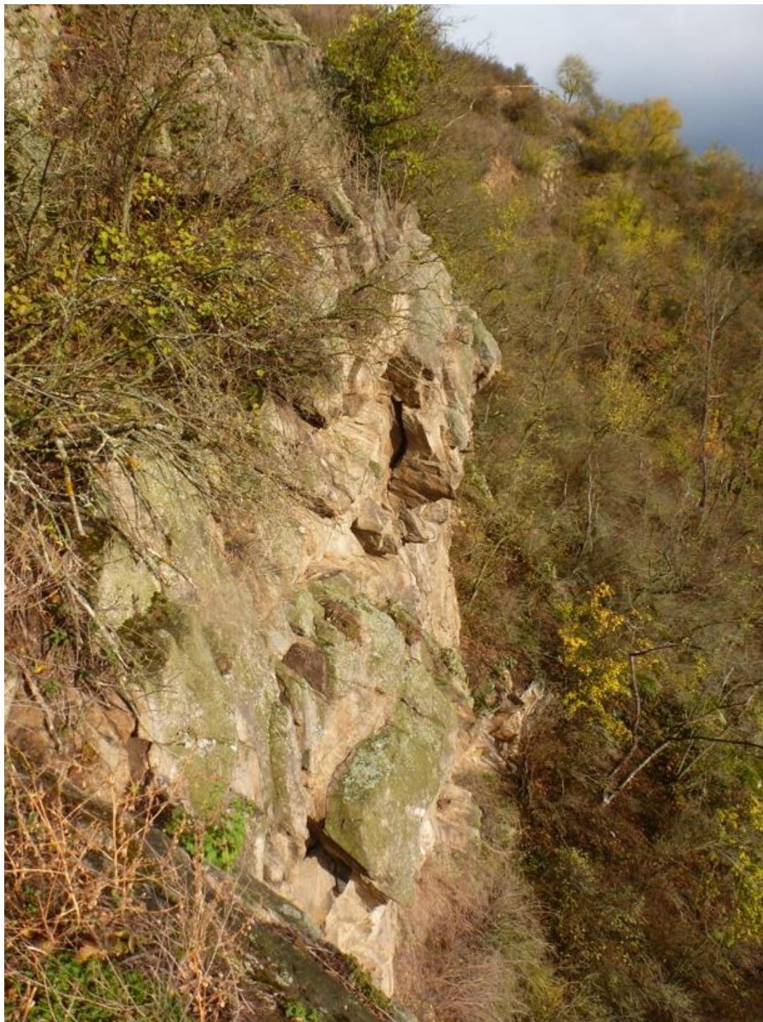
Část skalní stěny s nestabilními přepisnými bloky, které budou odtěženy.
