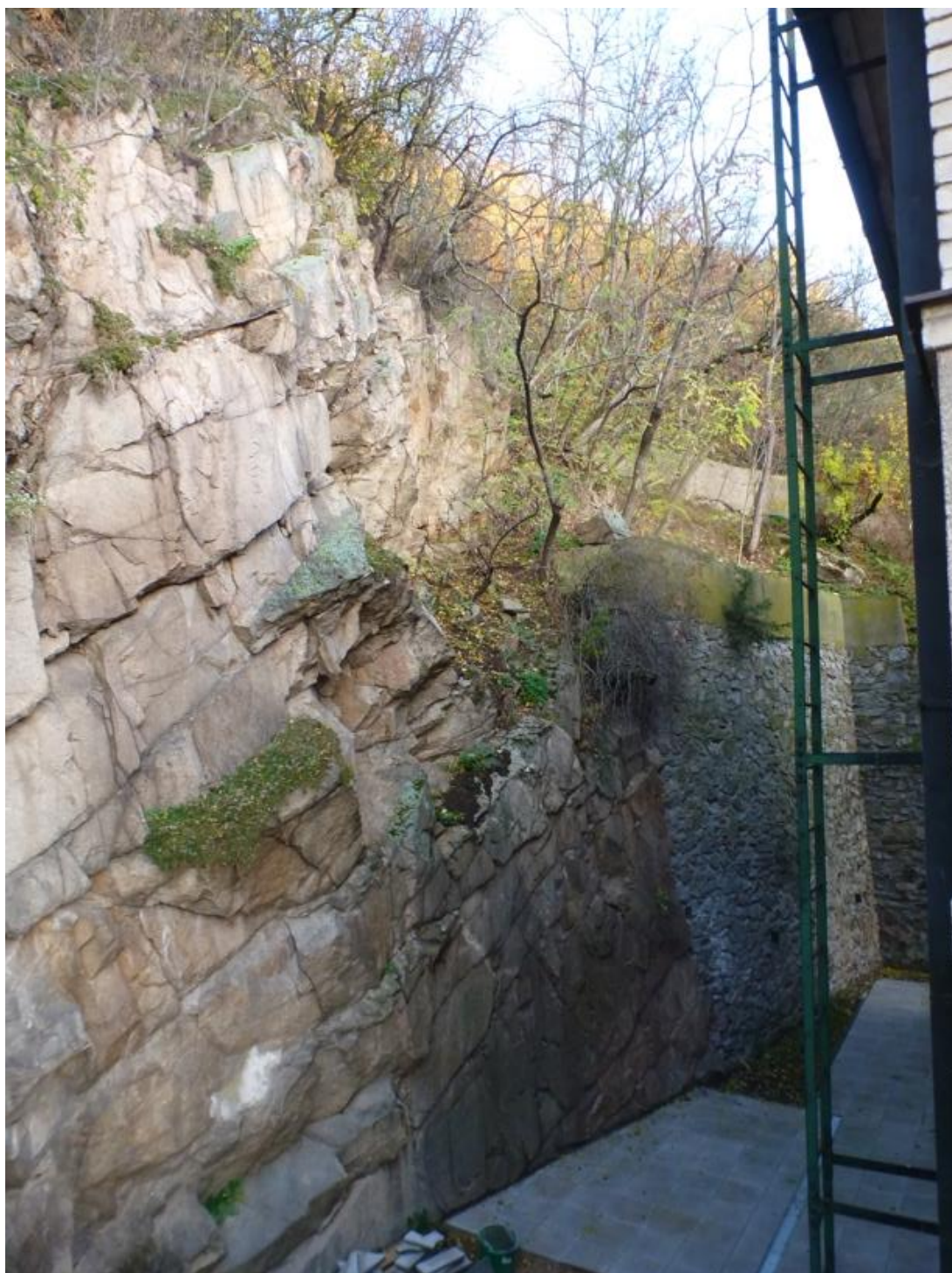
Po odstranění vegetace a očištění bude skal. stěna zajištěna oc. sítí 80 x 100 mm.
