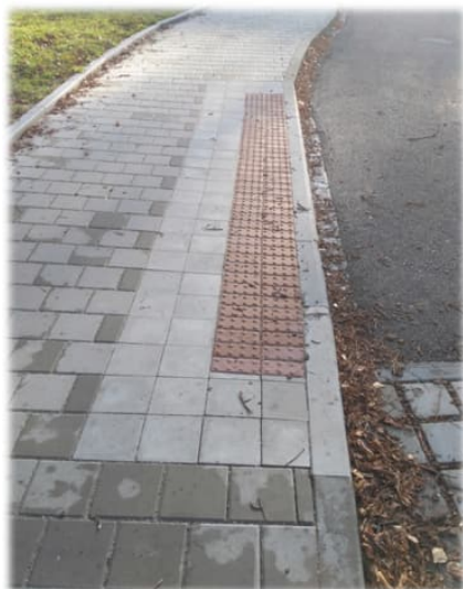
Ilustrační fotografie – chodník s varovným pásem šířky 40 cm z reliéfní červené dlažby, v šíři 40 cm lemováno rovinnou betonovou dlažbou 20×20 cm bez fazety.
