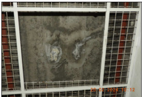
Obrázek 41 – pole 4, vpravo u severní rampy, zatékání do nosné konstrukce
