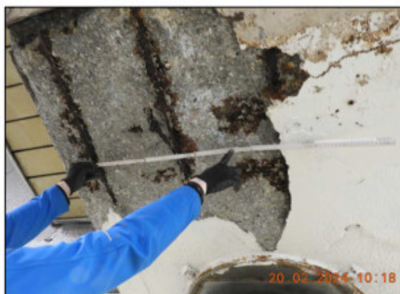
Obrázek 44 – příčník na podpěře 5, vpravo, masivní zatékání, odpad krycí vrstvy betonu a koroze výztuže
