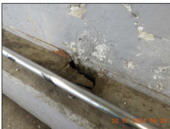
Obrázek 24 – jižní rampa, silné zatékání na severní stěně
