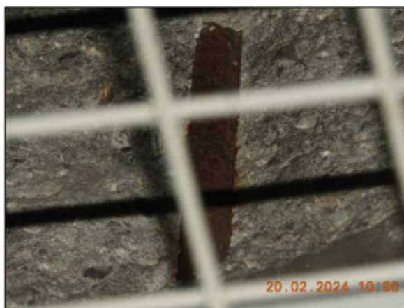
Obrázek 39 – pole 5, zatékání a odpad krycí vrstvy výztuže a její koroze
