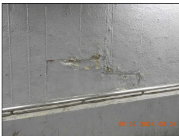
Obrázek 12 – severní rampa, zatékání na severní stěně
