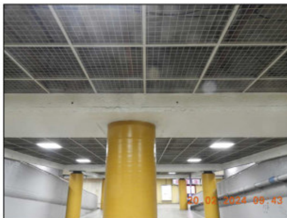
Obrázek 33 – podpěra 3, uložení bez ložisek
