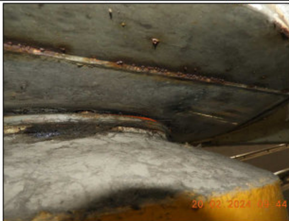
Obrázek 34 – ložisko pravé na P4, koroze kluzné plochy, deformace kluzné vrstvy z PTFE
