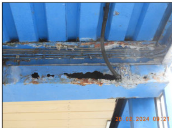
Obrázek 25 – jižní rampa, masivní koroze ocelové konstrukce přístřešku, ztráta materiálu, ohrožení bezpečnosti provozu
