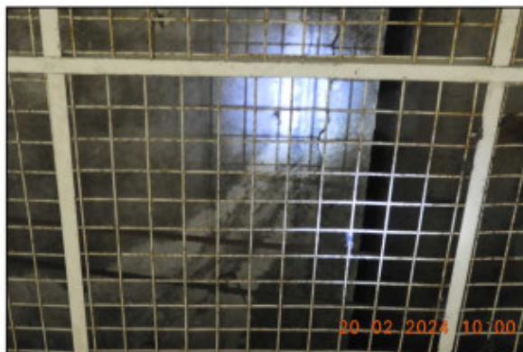
Obrázek 37 – zatékání do nosné konstrukce v poli 5
