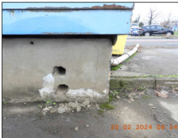
Obrázek 29 – jižní nástupiště, koroze oplechování, odpad omítky, odvodnění je nevhodně zaústěno na komunikaci
