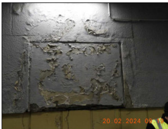
Obrázek 23 – jižní rampa, zatékání na stěně u příčniku
