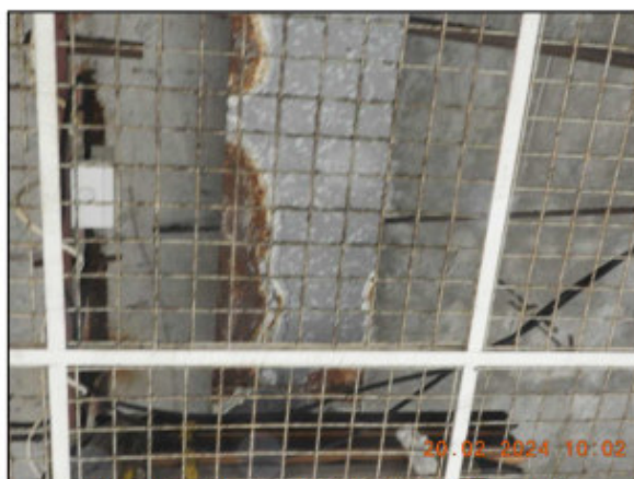
Obrázek 38 – koroze kabelových žlabů v poli 5
