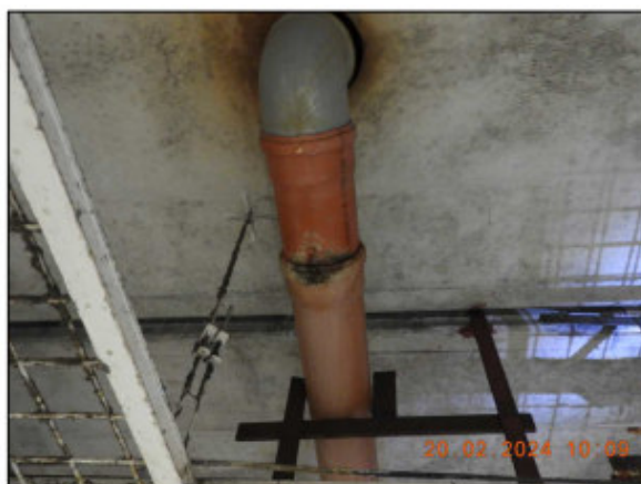
Obrázek 47 – Odvodnění ve 4. poli, netěsnost ve spoji potrubí
