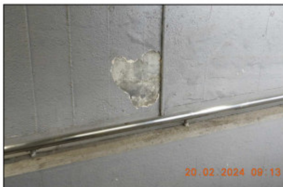
Obrázek 20 – střední rampa, severní stěna, odpad omítky
