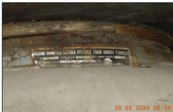
Obrázek 31 – ložisko druhé zprava na P2, koroze a vyhřezlý elastomer z hrnce
