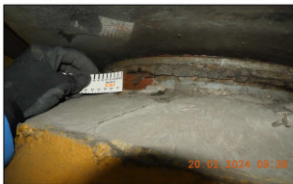
Obrázek 32 – ložisko třetí zprava na P2, koroze a vyhřezlý elastomer z hrnce
