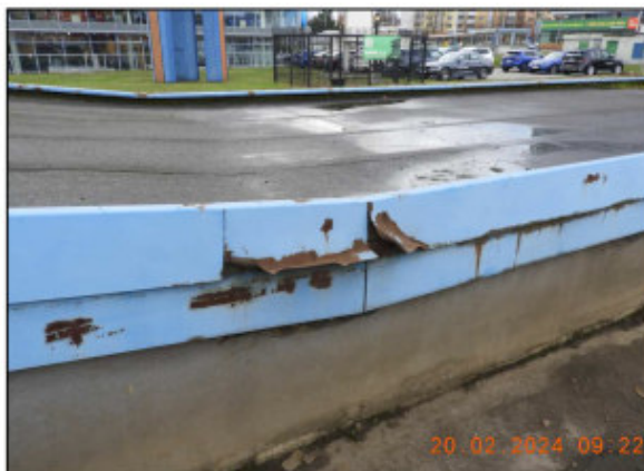
Obrázek 28 – jižní kolej, oplechování přístřešku, deformace a koroze
