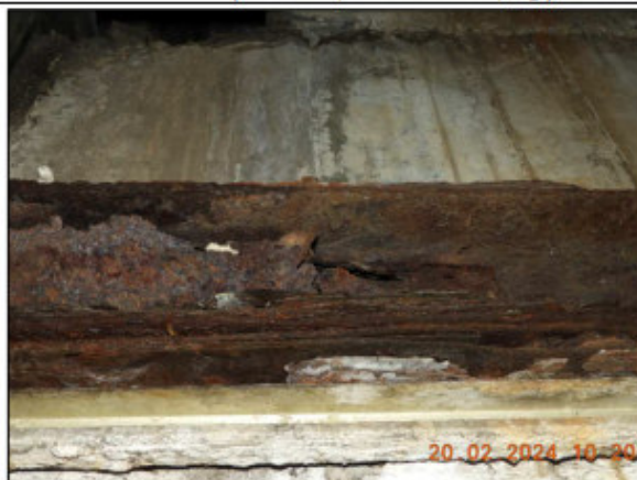
Obrázek 46 – podpěra 5, vlevo, masivní plošná koroze ocelových nosníků konstrukcí kotvicích obkladové panely, výrazný úbytek materiálu, odpadávání korozních zplodin do prostor přístupných veřejnosti
