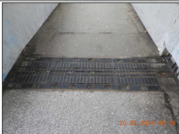
Obrázek 13 – severní rampa – kobercový mostní závěr
