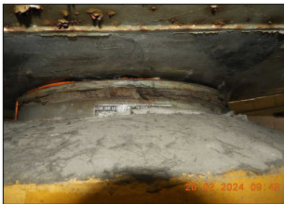
Obrázek 35 – levé ložisko na P4, vytržená kluzná vrstva, koroze kluzné plochy i hrnce
