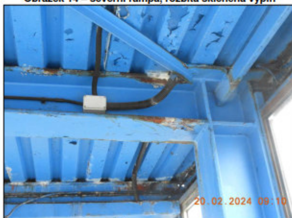
Obrázek 15 – severní nástupiště – koroze ocelové konstrukce přístřešku
