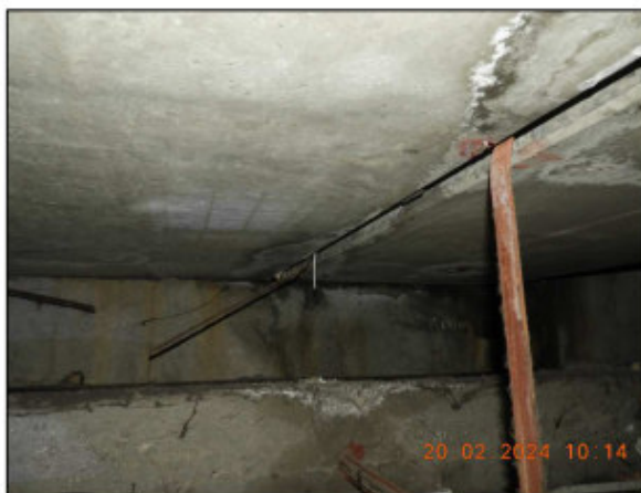
Obrázek 42 – pole 5 u opěry 6, zatékání do nosné konstrukce
