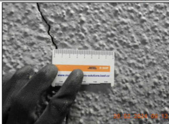
Obrázek 19 – svislá trhlina na jižní stěně střední rampy (šířka 3 mm)
