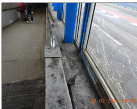
Obrázek 14 – severní rampa, rozbitá skleněná výplň
