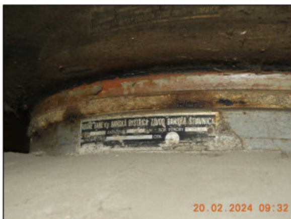
Obrázek 30 – pravé ložisko na P2, koroze hrnce a kluzné plochy
