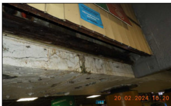
Obrázek 45 – podpěra 5, vlevo, zatékání a degradace betonu
