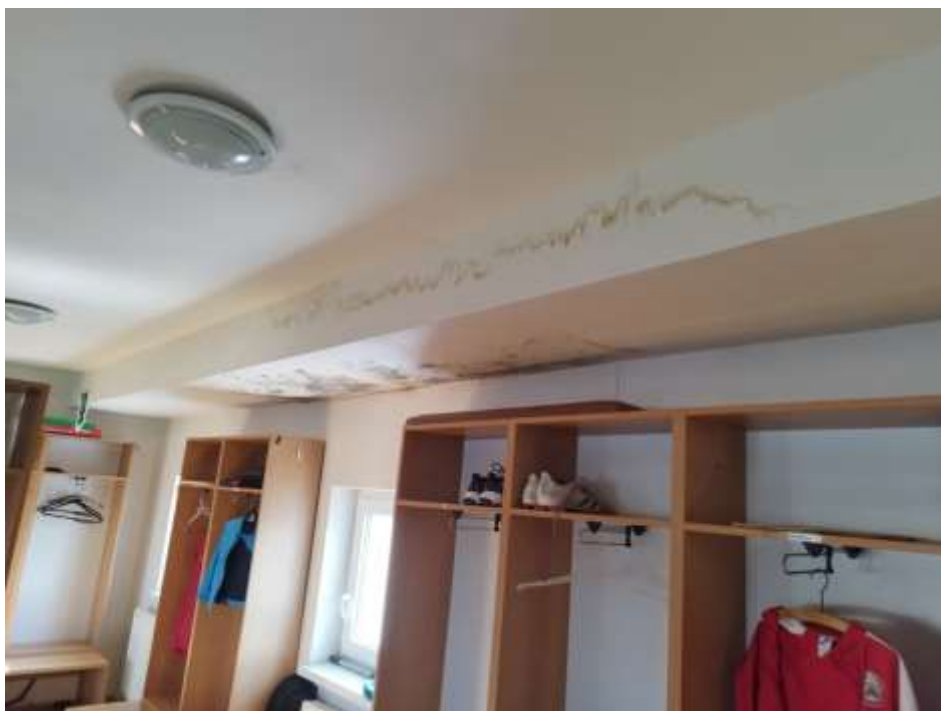
obr.3 - celkový pohled na poškozený podhled
