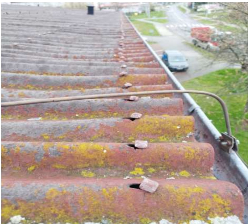
obr.1. detail poškozené střechy
