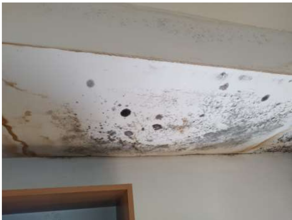
obr.4 detail poškození s postupující plísní
