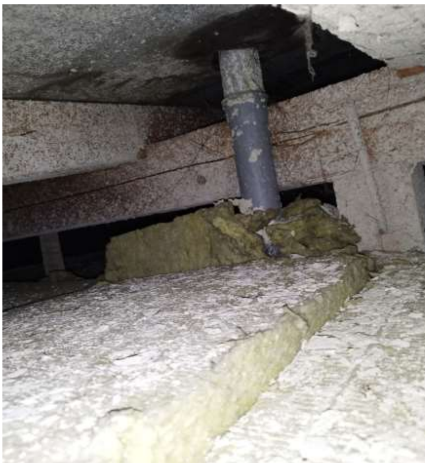
obr. 6. - potřísnění podstřešního prostoru až po středovou vaznici
