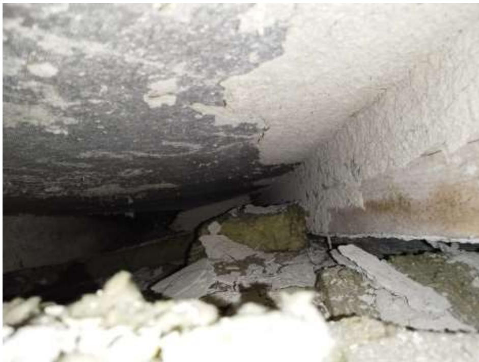
obr. 5 - stav podstřešního prostoru - znečištění maltou, poškozená tepelná izolace
