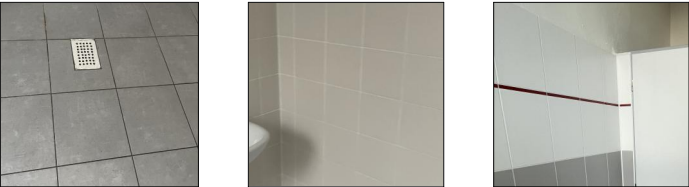
STÁVAJÍCÍ KERAMICKÁ DLAŽBA - 333/333 mm STÁVAJÍCÍ KERAMICKÝ OBKLAD - 200/200 mm STÁVAJÍCÍ KERAMICKÝ OBKLAD - 250/330 mm
