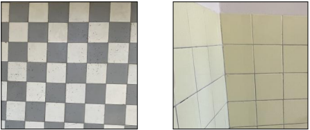
STÁVAJÍCÍ KERAMICKÁ DLAŽBA - 100/100 mm STÁVAJÍCÍ KERAMICKÝ OBKLAD - 150/150 mm
