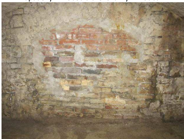
Foto č.40 – neprověřený zazděný otvor ve štitové stěně sklípku s možnou návazností na další prostor
