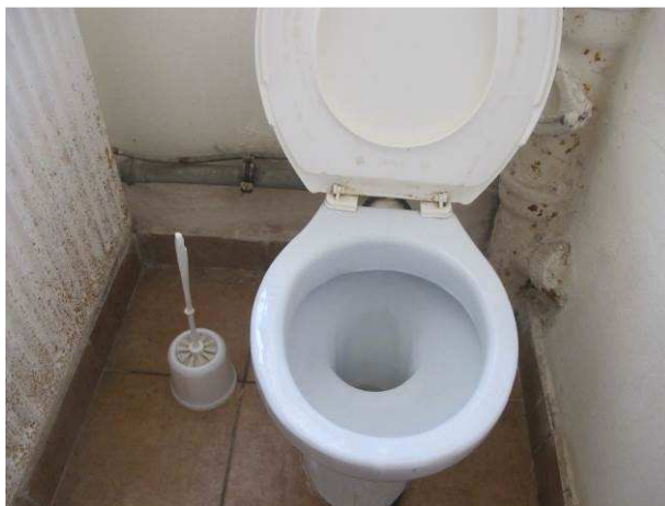
Foto č.26 – vlhkostní zátěž od zemní vlhkosti a působení koroze z důvodu vysoké vnitřní relativní vlhkosti na kovové konstrukce v prostorách sociální
