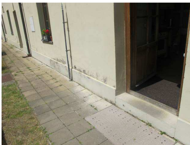
Foto č.8 – degradace omítek nad soklem z cementových omítek
