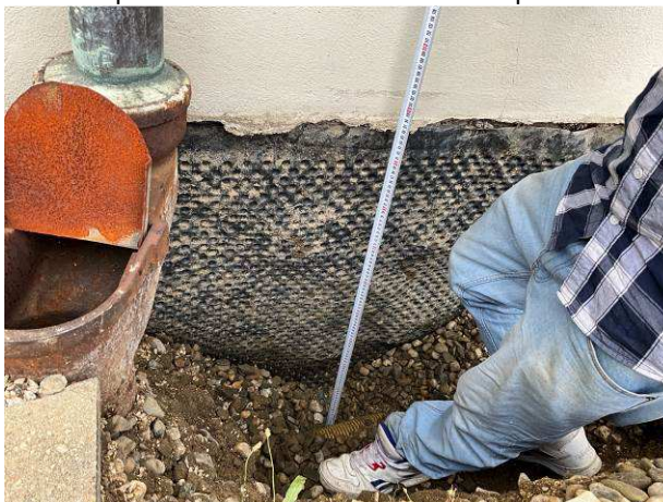
Foto č.42 – sonda po obnažení trubního vedení se zcela promáčenou vrstvou obsypového materiálu říčním kamenivem
