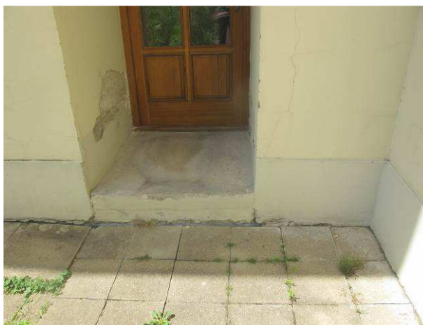
Foto č.10 – vlhkostní mapy s opadáváním omítek u vchodu z nádvoří do společných prostor
