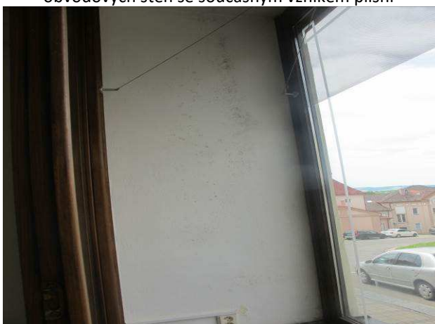
Foto č.30 – výskyt plísní ve výkladcích provozovny Cykloportu z důvodu výskytu tepelných mostů a omezeného větrání
