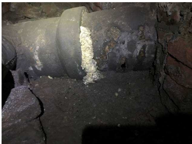
Foto č.45 – dodatečné provizorní utěsnění trubního vedení
