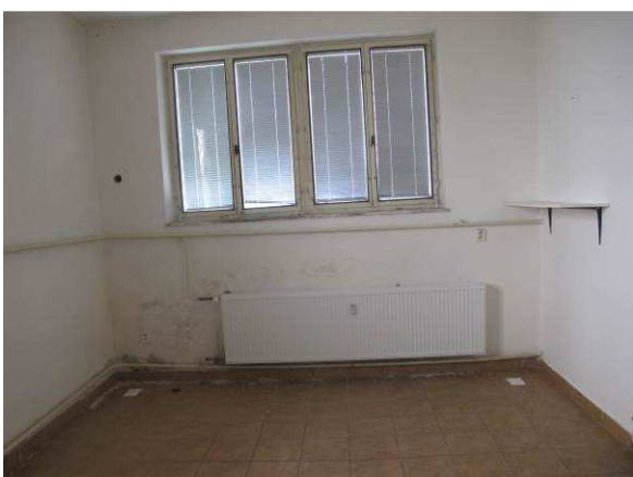
Foto č.33 – poškození omítek obvodové zdi z důvodu omezené funkčnosti vnější izolace novodobého přístavku
