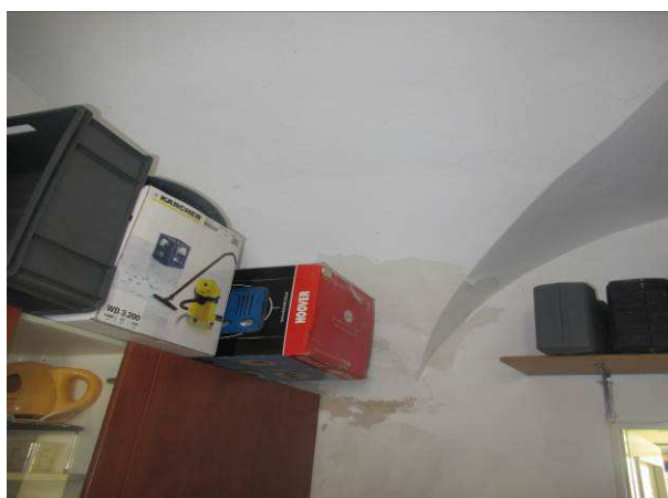
Foto č.18 – sprášování omítek se solnými výkvěty v klenbách z důvodu kondenzace a vysoké relativní vlhkosti
