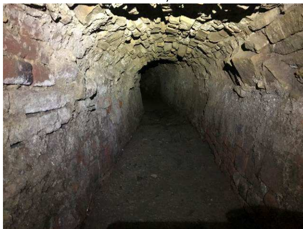
Foto č.46 – charakter provedení původního kanálku
