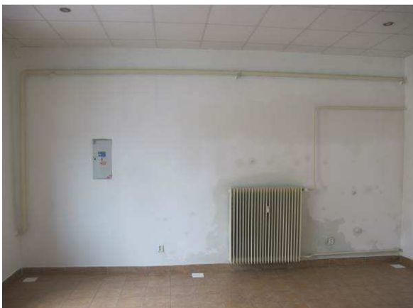
Foto č.31 – vlhkostní projevy mezi úrovní přízemí a jeho snížené části, se současným zakrytím původních větracích otvorů podlahy, kdy docházelo k rozsáhlému víření ztuchliny
