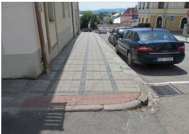
Foto č.3 – bezeškodný odvod srážkových vod z chodníku
