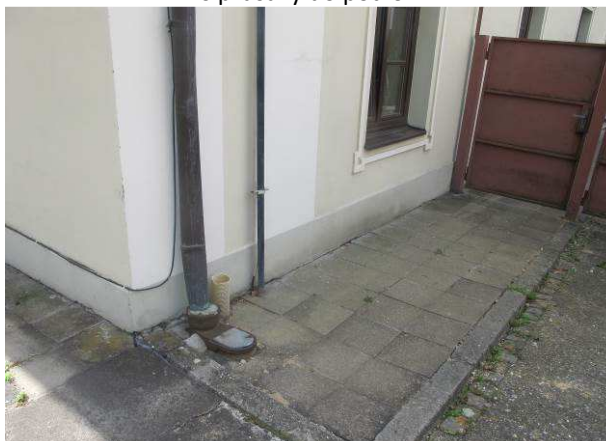
Foto č.6 – vyústění hadice drenážního systému pro přívod vzduchu v nároží objektu
