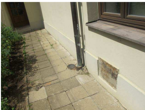
Foto č.9 – vývod s mřížkou pro odvětrání malého sklípku (1.PP)
