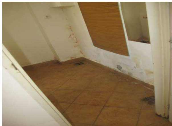
Foto č.20 – vlhkosti obvodových zdí s plísněmi od zemní vlhkosti a zřejmě i od netěsnosti kanalizačních stupaček
