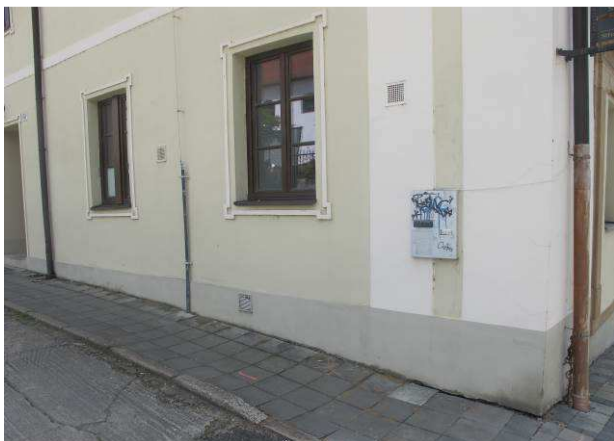
Foto č.5 – nedostatečný způsob odvětrávání (mřížka pod oknem) původního kanálku z doby výstavby, zcela nefunkční odvětrávací a větrací mřížky v úrovni oken pro odvětrání z vnitřních prostor (podlahy)
