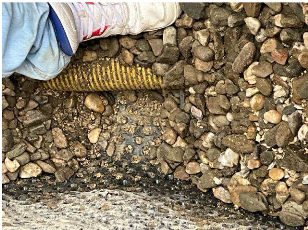
Foto č.43 – detail uložení drenáže bez funkčního podkladu pro odvod průsakových
