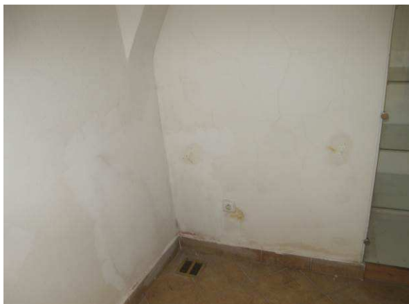
Foto č.19 – vysoká úroveň vlhkostních map v prostorách solária se vznikem plísní z důvodu vztlínající zemní vlhkosti a nedostatečného větrání
