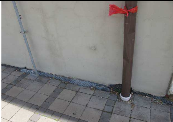
Foto č.2 – detail vady provedení svislé izolace bez ukončovacích lišt, dešťové svody bez lapačů splavenin pro kontrolu v rámci zachovné údržby
