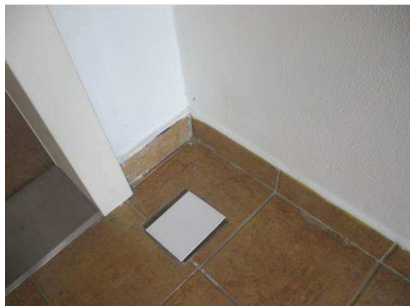
Foto č.32 – detail krytky původního větracího otvoru z podlahy
