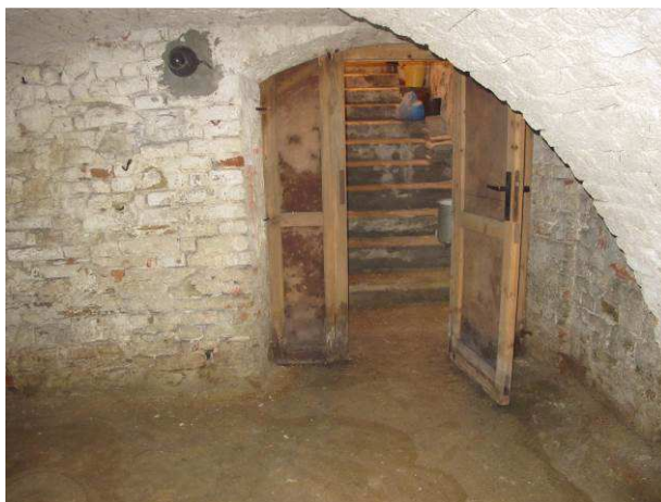
Foto č.38 – předělovací dřevěné dveře mezi přístupovým schodištěm a sklípkem, které jsou napadeny hnilobou a dřevokaznými houbami
