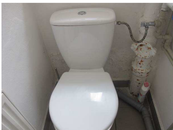
Foto č.23 – degradace omítek se sprášováním maleb u sociálního zařízení
