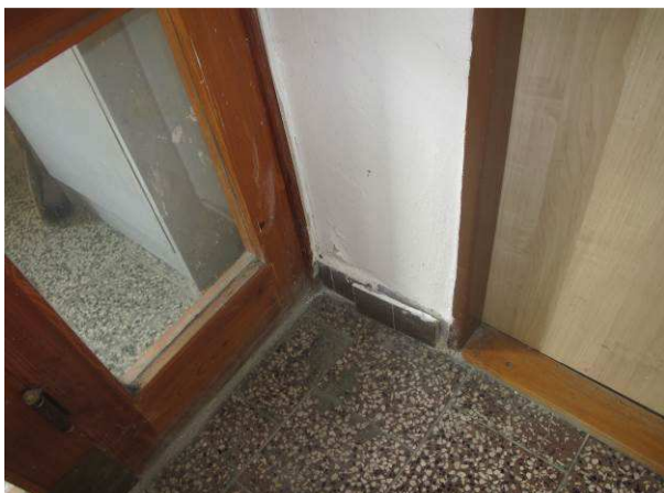
Foto č.15 –vlhkost u předělovacích dveří do chodby, odtržení soklíku od podkladu při vstupu do suterénu
