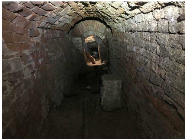
Foto č.44 – způsob provedení vyzděného kanálku z doby výstavby s položením trubního vedení (pod prostory 1.NP)
