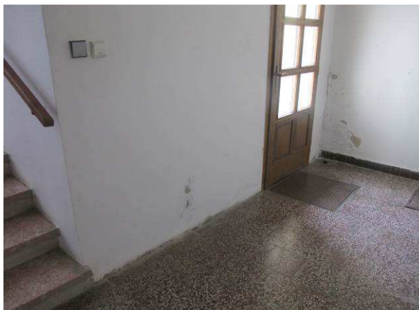
Foto č.14 – degradace omítek u dveří z nádvoří do společných prostor přístupové chodby do bytových jednotek v 2.NP
