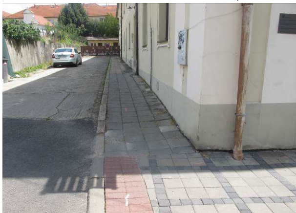
Foto č.4 – fasáda u příjezdové cesty do areálu, propadlé chodníky bez možnosti odvodu srážkových vod a s průsaky do podloží
