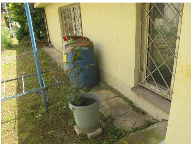
Foto č.11 – okapový chodník z velkoplošné betonové dlažby podél novodobého přístavku
