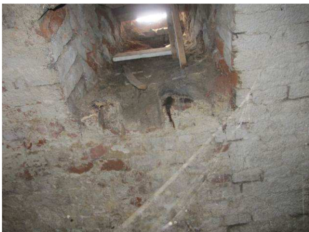
Foto č.39 – stávající prostor ze sklepa, který bude možno využít pro účinné odvětrávání prostor v suterénu
