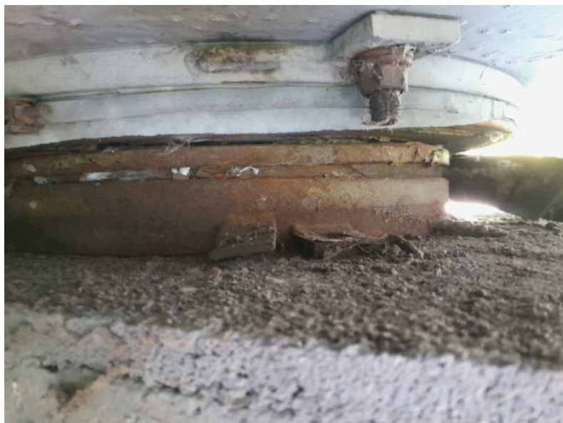
Obr. 3.84 – ložisko Pi2-L-2, plošná povrchová koroze ložiska, místy zpuchřelé těsnění náklonné spáry
