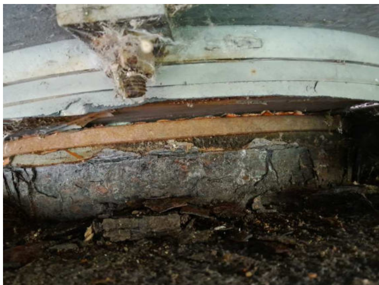
Obr. 3.78 – ložisko OP1-L, velmi silná koroze hrnce ložiska, významné oslabení tělesa hrnce
