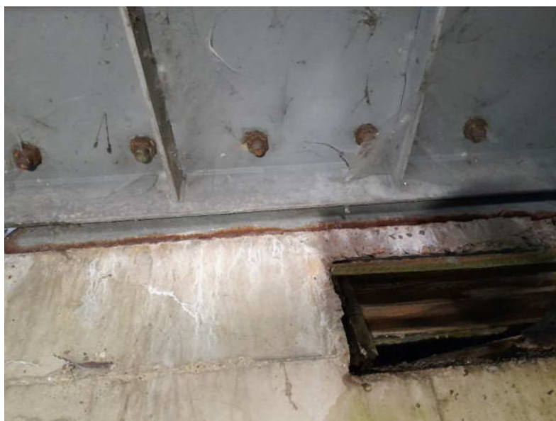
Obr. 3.34 – povrchová koroze šroubových spojů mostních závěrů nad opěrou OP3
