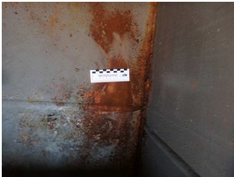
Obr. 3.42 – pravý parapetní nosník v poli 2, povrchová koroze dna nosníku v oblasti nad opěrou OP3
