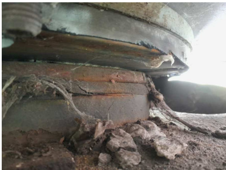
Obr. 3.89 – ložisko Pi2-P-2, lokální koroze ložiska, koroze zjištěna i u horní kluzné desky ložiska, trhлина v těsnění náklonné spáry
