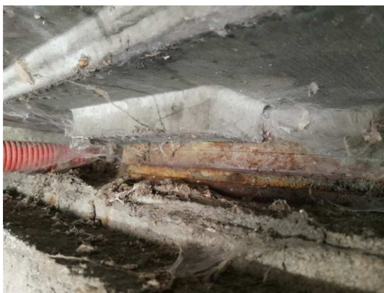
Obr. 3.94 – ložisko OP3-L, plošná koroze hrnce i horní desky ložiska
