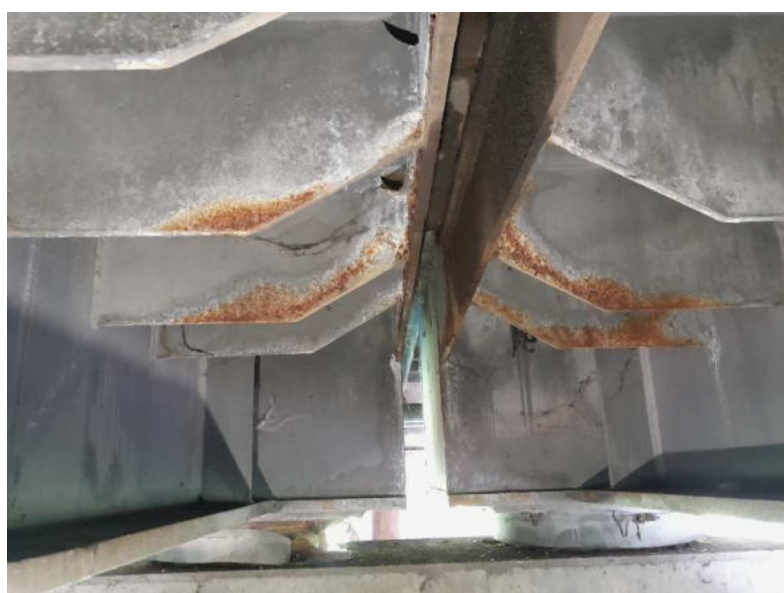
Obr. 3.38 – povrchová koroze koncového příčnicku a podélných výztuh mostovky nad pilířem P2
