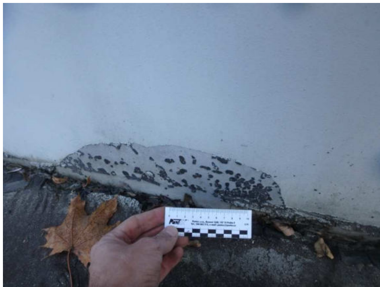
Obr. 3.75 – pravý parapetní nosník v poli 2, lokální poruchy protikorozní ochrany na pravém boku nosníku na styku s chodníkem
