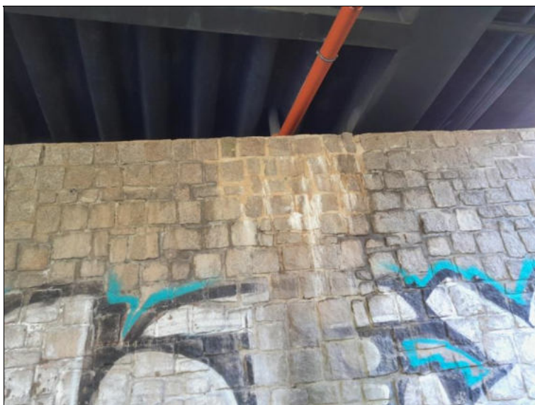
Dřík opěry OP3, v horní části zatékání a výluhy ve spárování.
