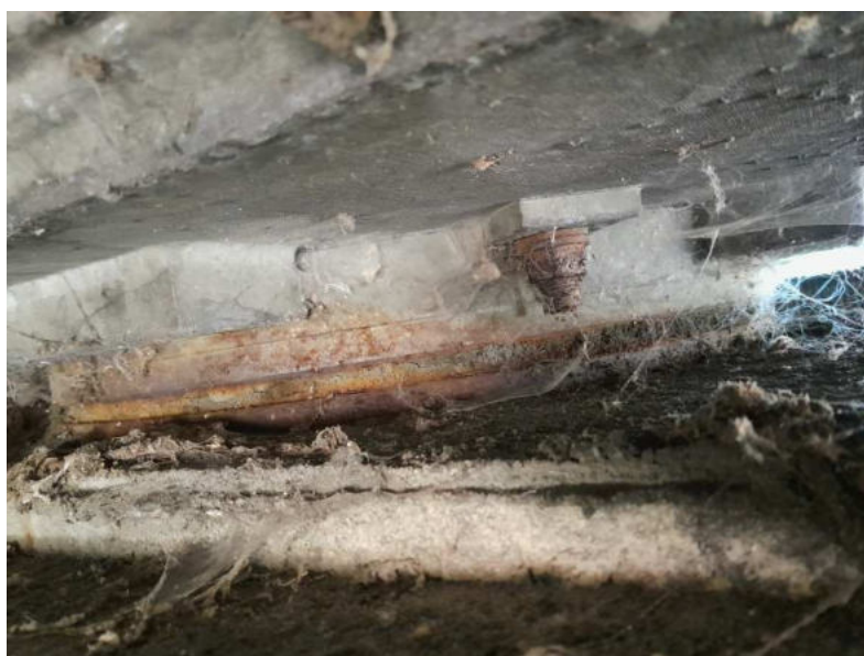
Obr. 3.93 – ložisko OP3-L, plošná koroze hrnce i horní desky ložiska, koroze kotevních šroubů
