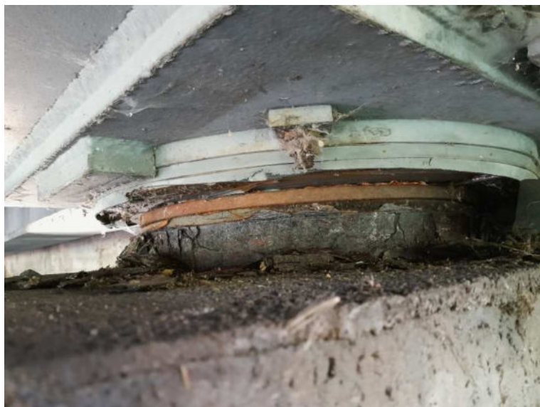
Obr. 3.77 – ložisko OP1-L, velmi silná koroze hrnce ložiska, významné oslabení tělesa hrnce
