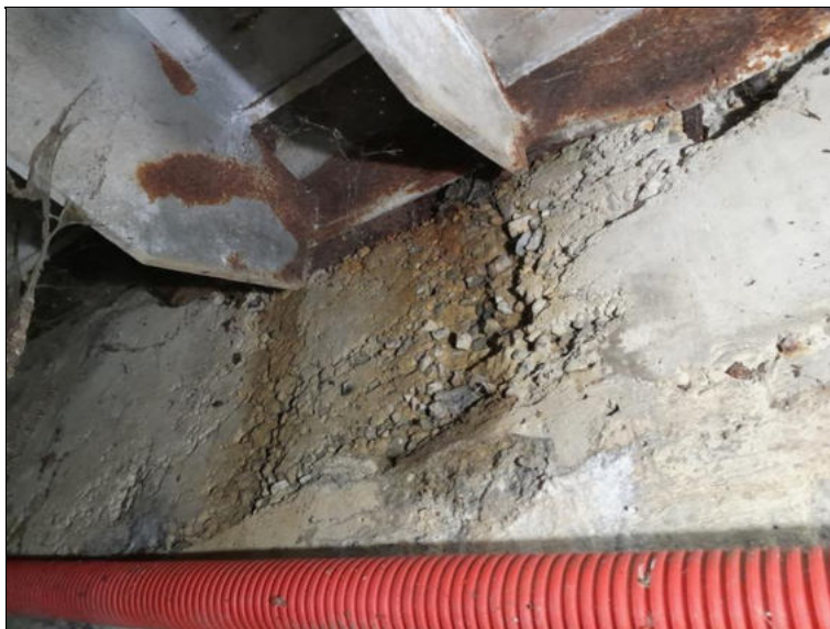
Štěrková hnízda v závěrné zdi opěry OP3, povrchová koroze koncové části nosné konstrukce.
