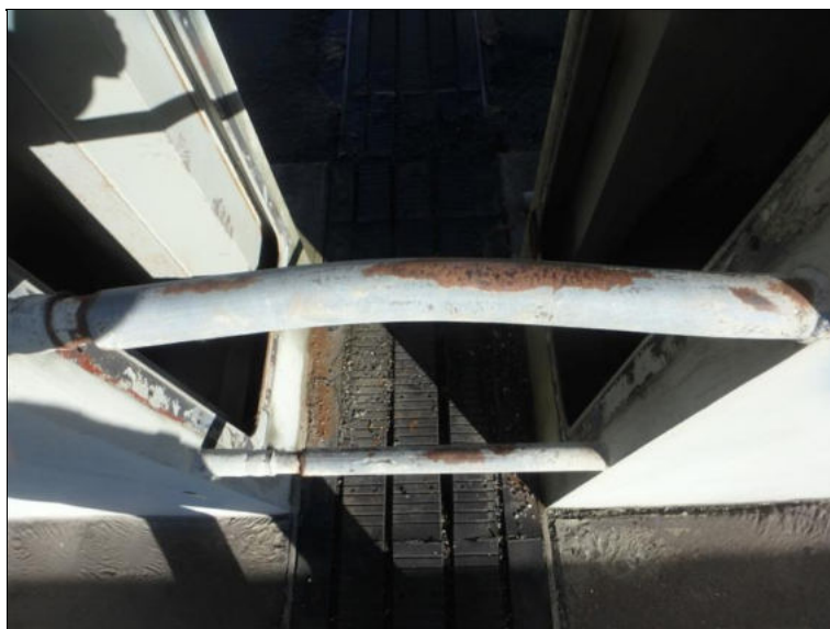
Deformované zábradlí nad pilířem P2, povrchová koroze.
