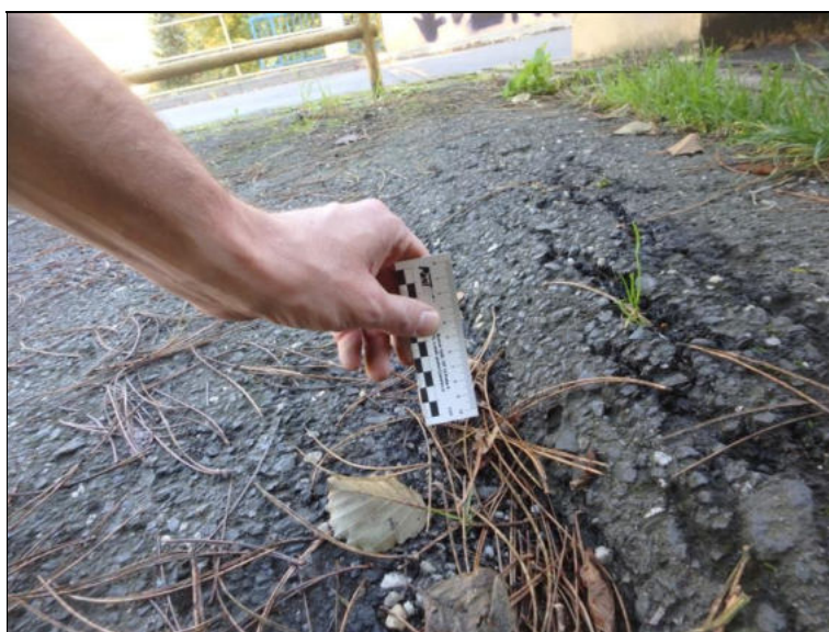
Deformace chodníku na pravé straně před opěrou OP1.
