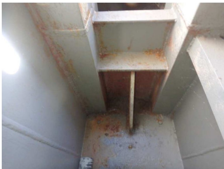
Obr. 3.49 – pravý parapetní nosník v poli 1, lokálně poškozená protikoroze ochrana v koncové části nosníku nad pilířem P2
