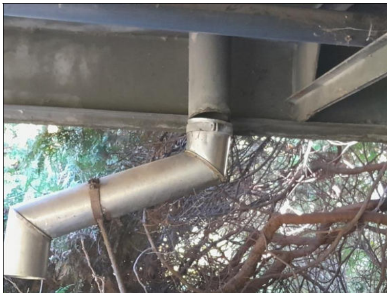
Rozpojený svod odvodnění u opěry OP3.
