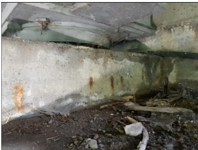
Levé ložisko na opěře OP1, silné zatékání v okolí ložiska, prokreslená korodující betonářská výztuž podložiskového bločku.
