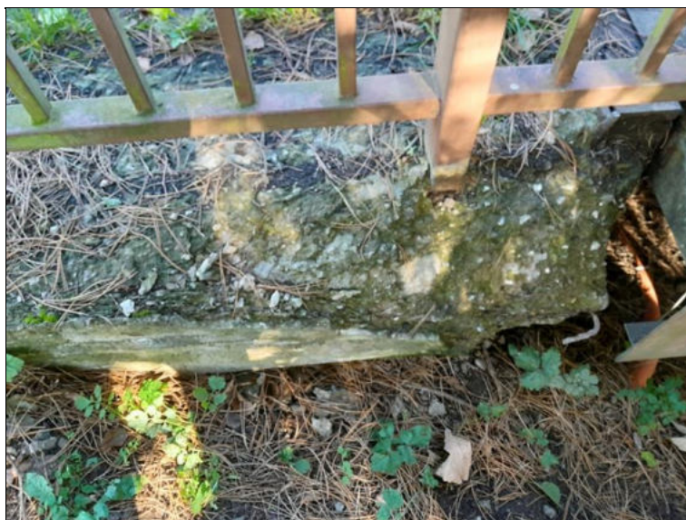
Degradace horního líce římsy na předmostí na pravé straně nad opěrou OP1.
