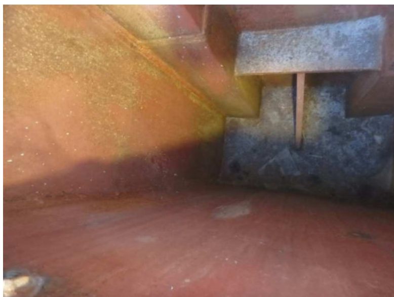
Obr. 3.55 – pravý parapetní nosník v poli 1, lokálně poškozená protikoroze v koncové části nosníku nad opěrou OP1, drobné nečistoty
