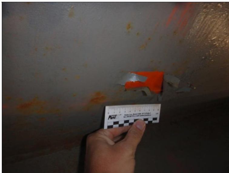
Lokálně poškozená protikorozní ochrana uvnitř komorového parapetního nosníku, pole 2, pravý nosník.
