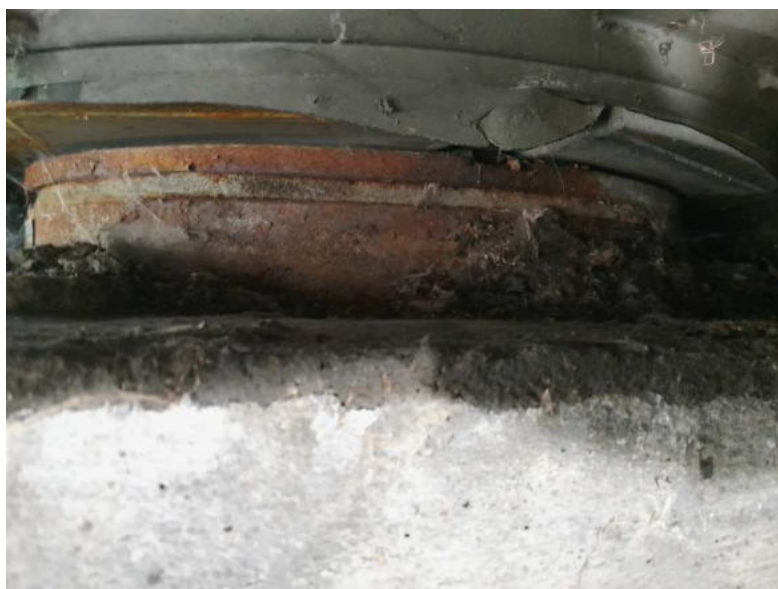
Obr. 3.90 – ložisko Pi2-P-2, lokální koroze ložiska, koroze zjištěna i u horní kluzné desky ložiska, trhлина v těsnění náklonné spáry
