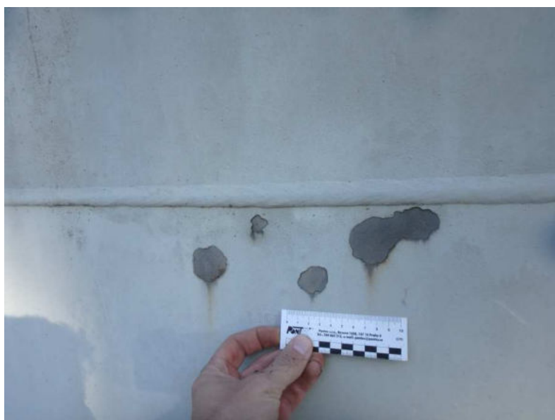
Obr. 3.74 – levý parapetní nosník v poli 2, lokální poruchy protikorozní ochrany na pravém boku nosníku
