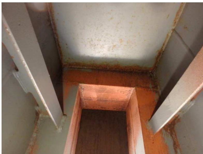
Obr. 3.67 – levý parapetní nosník v poli 2, lokálně poškozená protikorozní ochrana v koncové části nosníku nad pilířem P2, strop
