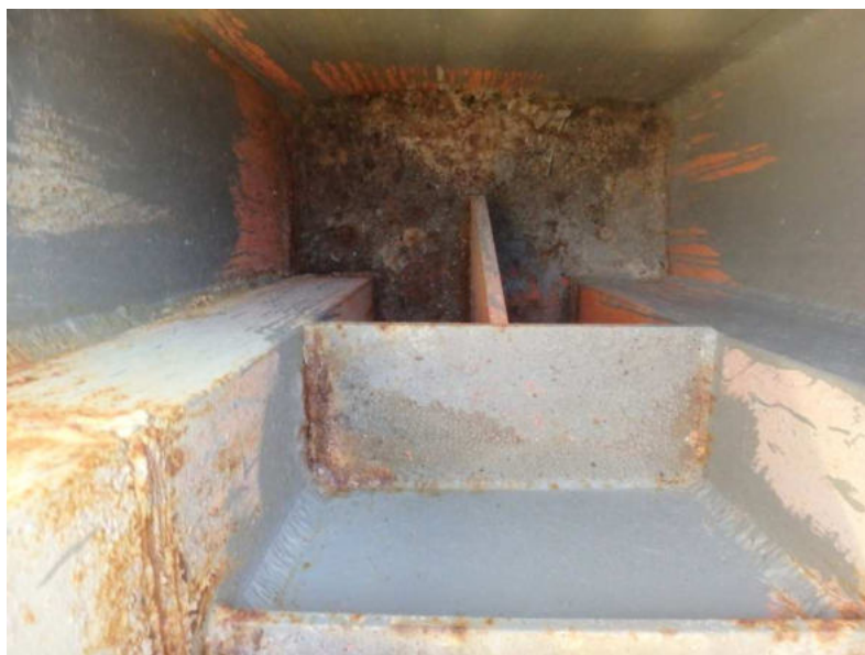
Obr. 3.72 – levý parapetní nosník v poli 2, lokálně poškozená protikorozní ochrana v koncové části nosníku nad opěrou OP3, dno, úbytek průřezové plochy do hloubky 1 mm
