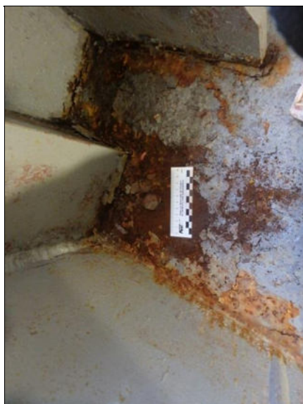
Koroze ocelové konstrukce uvnitř komorového parapetního nosníku, pole 1, pravý nosník.
