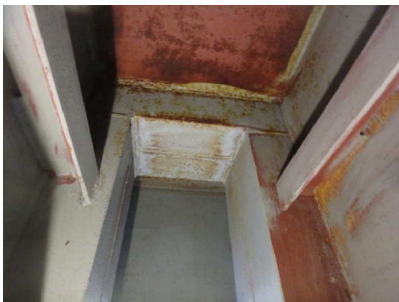
Obr. 3.59 – levý parapetní nosník v poli 1, lokálně poškozená protikoroze v koncové části nosníku nad opěrou OP1, strop
