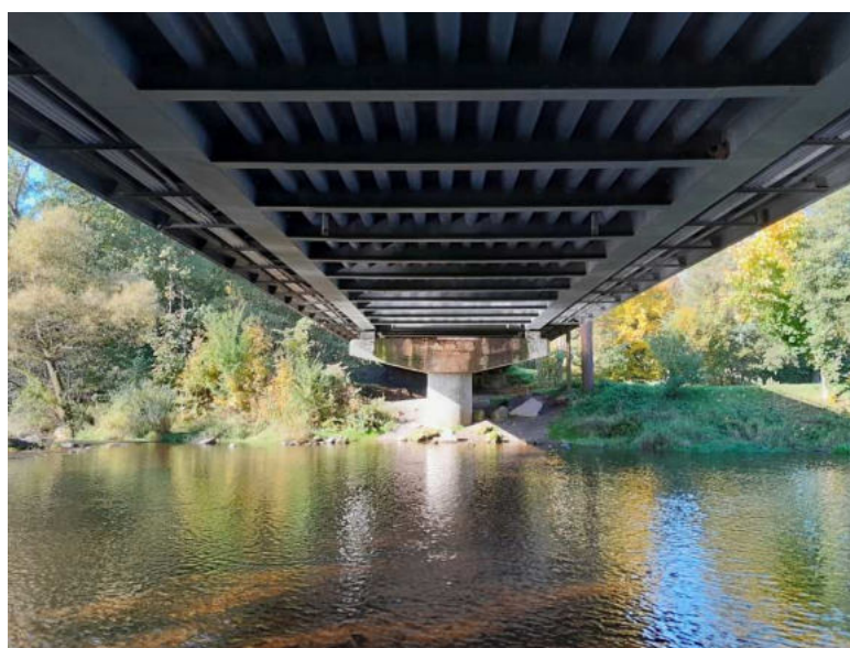
Obr. 3.32 – spodní líc ortotropní mostovky v poli 2
