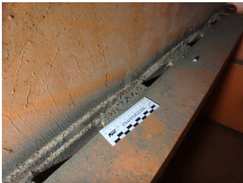
Obr. 3.46 – pravý parapetní nosník v poli 2, poškozená protikorozi ochrana a povrchová koroze v místě výztuhy nosníku
