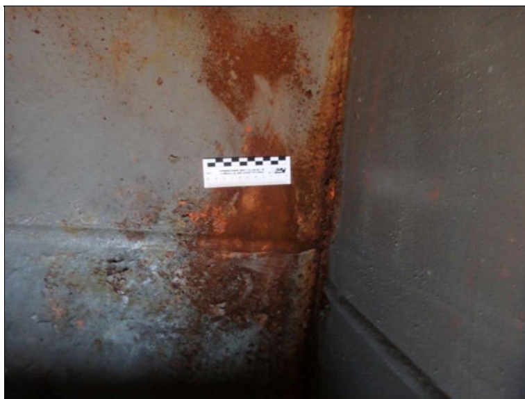
Koroze ocelové konstrukce uvnitř komorového parapetního nosníku, pole 1, pravý nosník.
