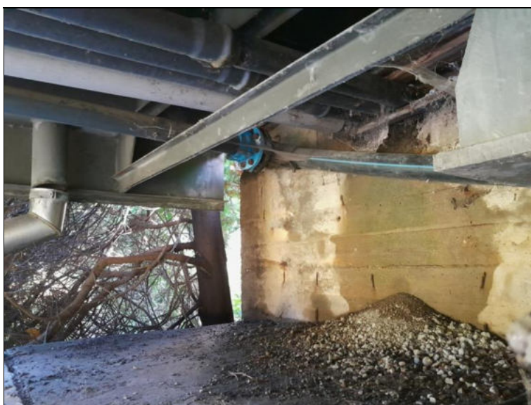
Zatékání na levé straně závěrné zdi opěry OP3, rozpojený svod odvodnění.
