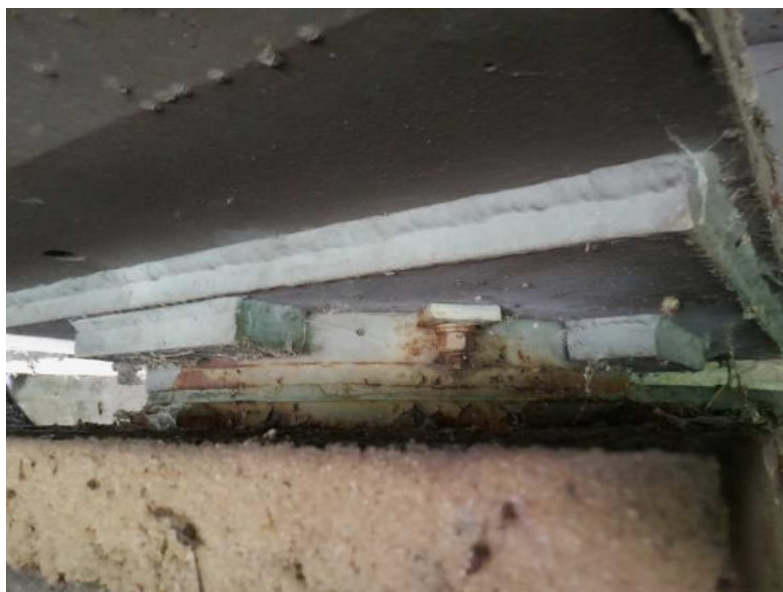
Obr. 3.80 – ložisko OP1-P, povrchová koroze hrnce ložiska, v okolí ložiska stopy po zatékání
