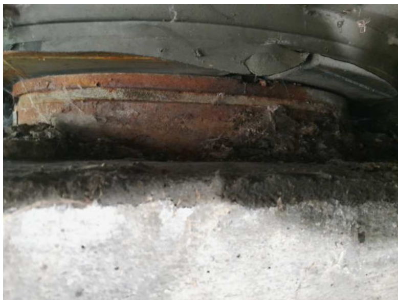
Obr. 3.92 – ložisko OP3-P, plošná koroze hrnce i horní desky ložiska
