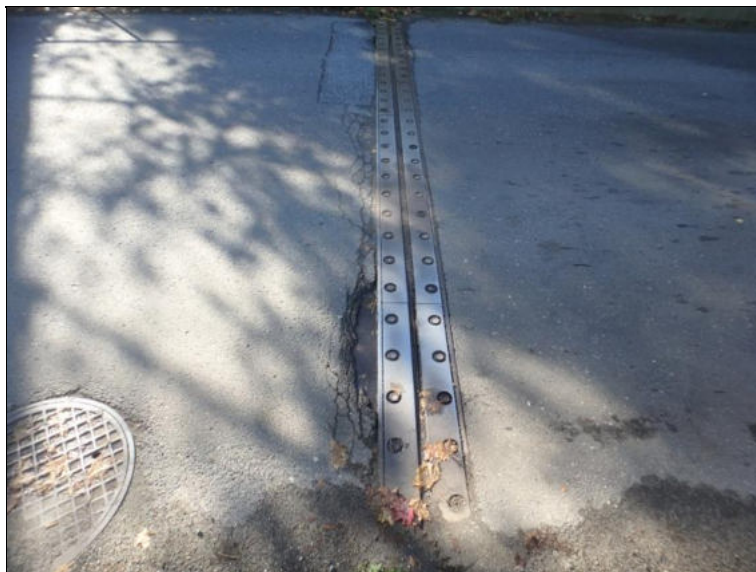
Mostní závěr nad opěrou OP3, výtluky ve vozovce u mostního závěru.
