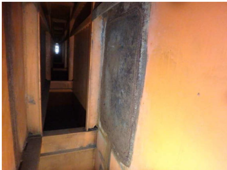
Obr. 3.45 – pravý parapetní nosník v poli 2, chybějící protikorozi ochrana v místě zavařeného vstupu do komory parapetního nosníku
