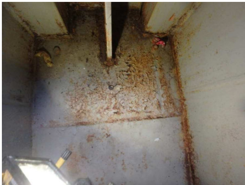
Obr. 3.65 – levý parapetní nosník v poli 2, lokálně poškozená protikorozní ochrana v koncové části nosníku nad pilířem P2, dno, úbytek průřezové plochy do hloubky 1 mm
