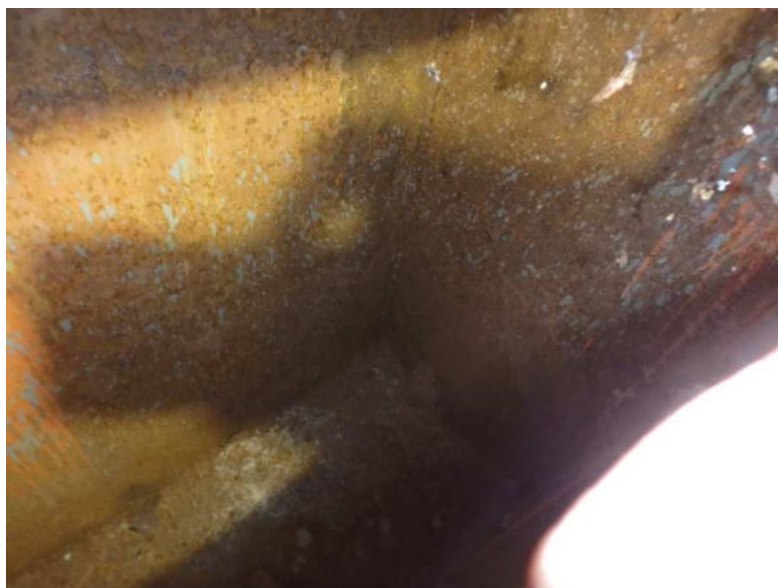
Obr. 3.66 – levý parapetní nosník v poli 2, lokálně poškozená protikorozní ochrana v koncové části nosníku nad pilířem P2, dno, úbytek průřezové plochy do hloubky 1 mm
