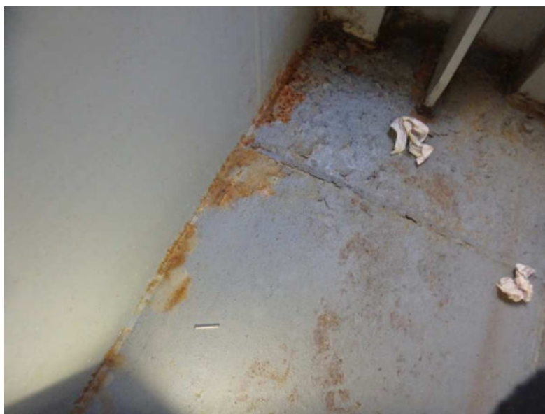
Obr. 3.62 – levý parapetní nosník v poli 1, lokálně poškozená protikoroze ochrana v koncové části nosníku nad pilířem P2, dno
