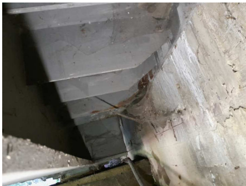
Obr. 3.36 – lokální povrchová koroze koncového příčnicku mostovky nad opěrou OP1
