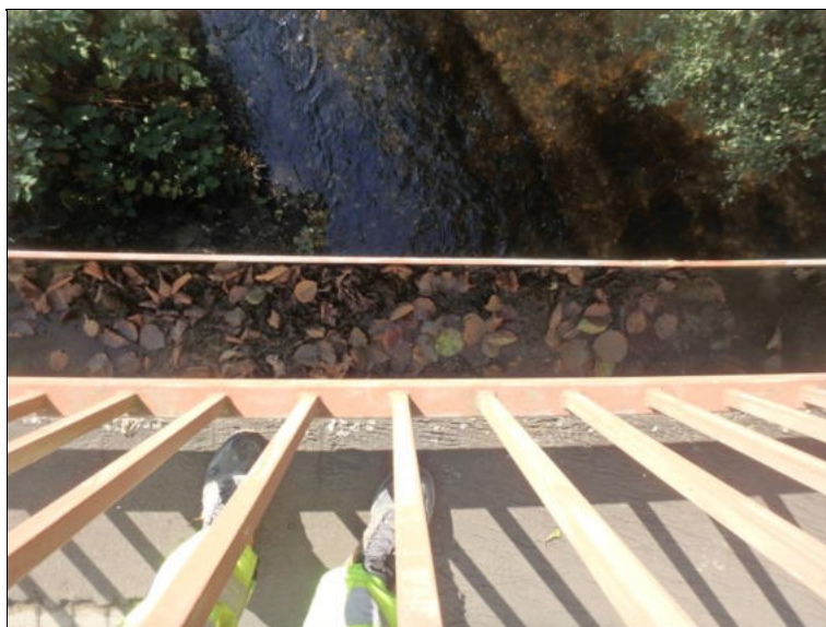
Množství nečistot v odvodňovacím žlabu na pravé straně.
