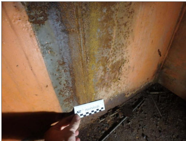
Plošná povrchová koroze uvnitř komorového parapetního nosníku v místě montážního svaru, pole 2, pravý nosník.
