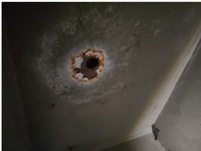
Obr. 3.40 – povrchová koroze na spodním líci desky mostovky
