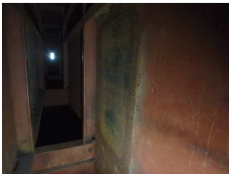
Obr. 3.52 – pravý parapetní nosník v poli 1, chybějící protikorozní ochrana v místě zavařeného vstupu do komory parapetního nosníku
