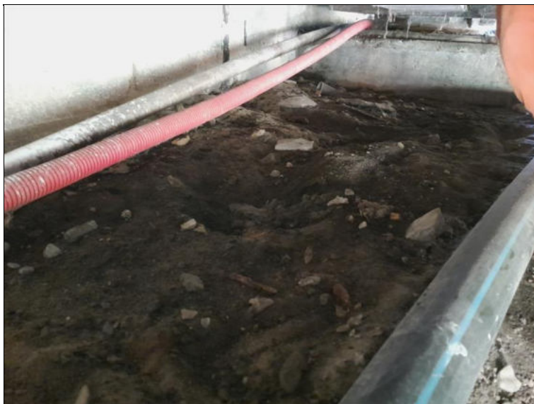
Nános nečistot na úložném prahu opěry OP3.
