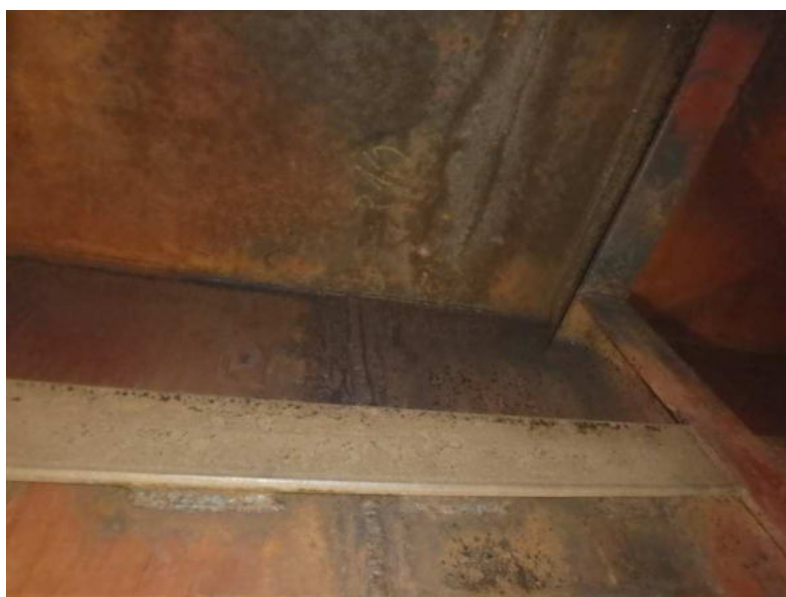
Obr. 3.53 – pravý parapetní nosník v poli 1, povrchová koroze v místě montážního svaru
