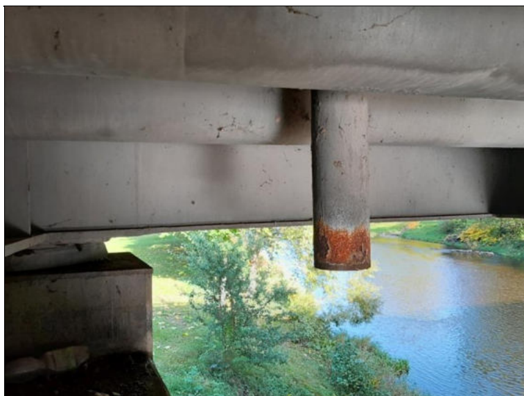
Koroze konce odvodňovacího svodu u pilíře P2.
