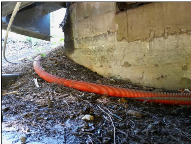
Množství nečistot na úložném prahu opěry OP1.
