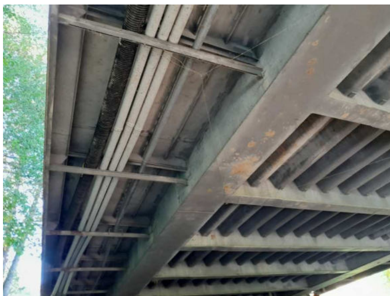
Obr. 3.35 – spodní líc ortotropní mostovky v poli 1
