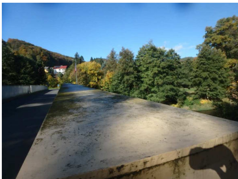
Obr. 3.73 – levý parapetní nosník v poli 2, stav protikorozní ochrany na horním líci nosníku
