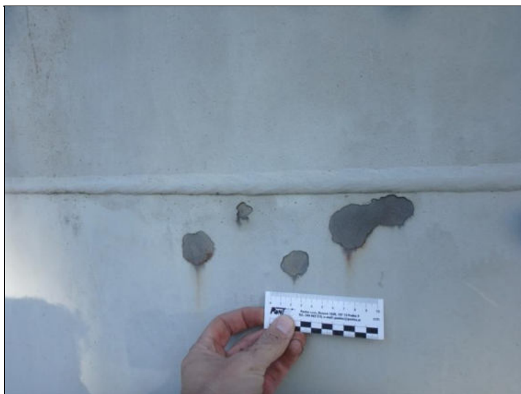
Lokálně poškozená protikorozní ochrana ocelového parapetního nosníku na pravé straně v poli 2, pravý bok.
