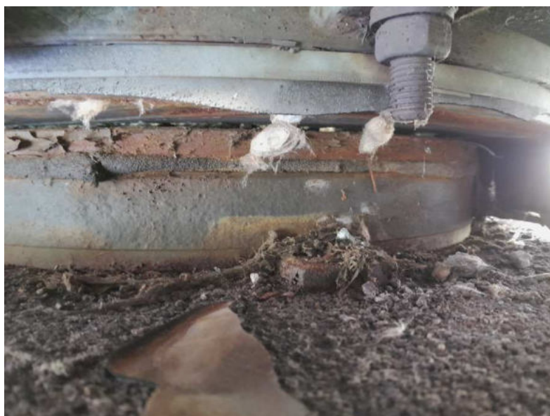
Obr. 3.87 – ložisko Pi2-P-2, lokální koroze ložiska, koroze zjištěna i u horní kluzné desky ložiska
