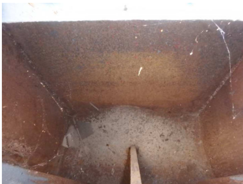
Obr. 3.50 – pravý parapetní nosník v poli 1, plošná povrchová koroze u dna nosníků v koncové oblasti nad pilířem P2, úbytek průřezové plochy do hloubky 1 mm, množství nečistot, detail
