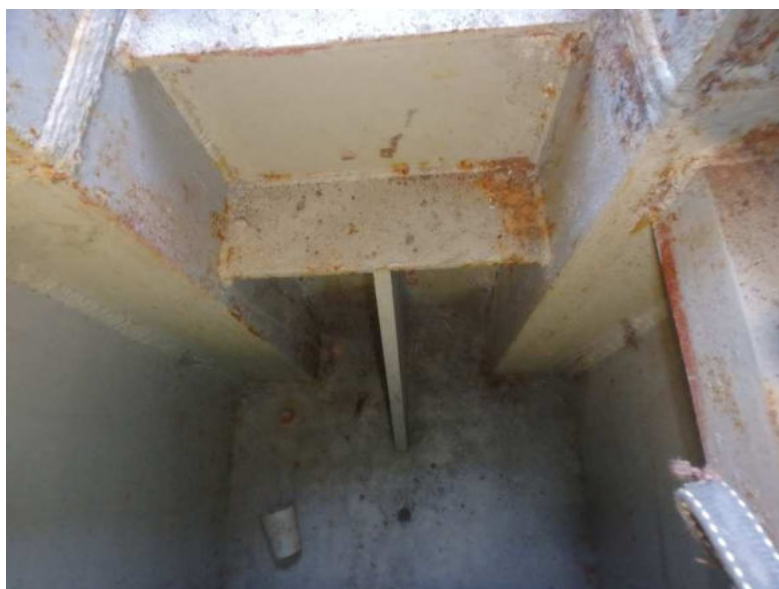
Obr. 3.58 – levý parapetní nosník v poli 1, lokálně poškozená protikoroze v koncové části nosníku nad opěrou OP1, dno, drobné nečistoty
