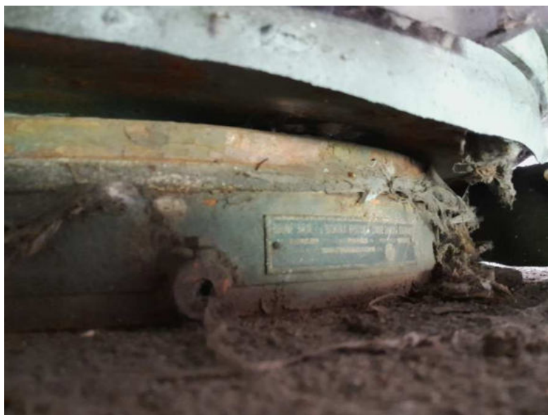
Obr. 3.86 – ložisko Pi2-P-1, lokální koroze ložiska, zejména pak horní desky ložiska, množství nečistot, nečitelný štítek ložiska
