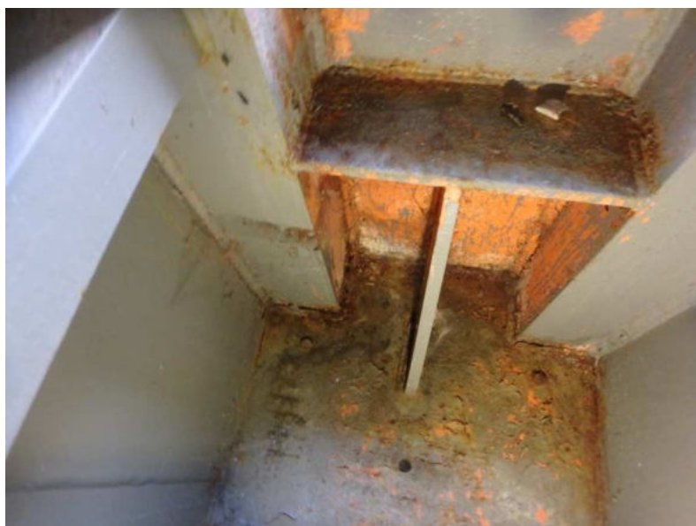
Obr. 3.71 – levý parapetní nosník v poli 2, lokálně poškozená protikorozní ochrana v koncové části nosníku nad opěrou OP3, dno
