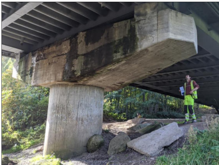
Pilíř P2, líc do pole 2, silné zatékání, plošná degradace betonu.
