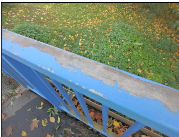
Plošně poškozená protikorozní ochrana horního madla.
