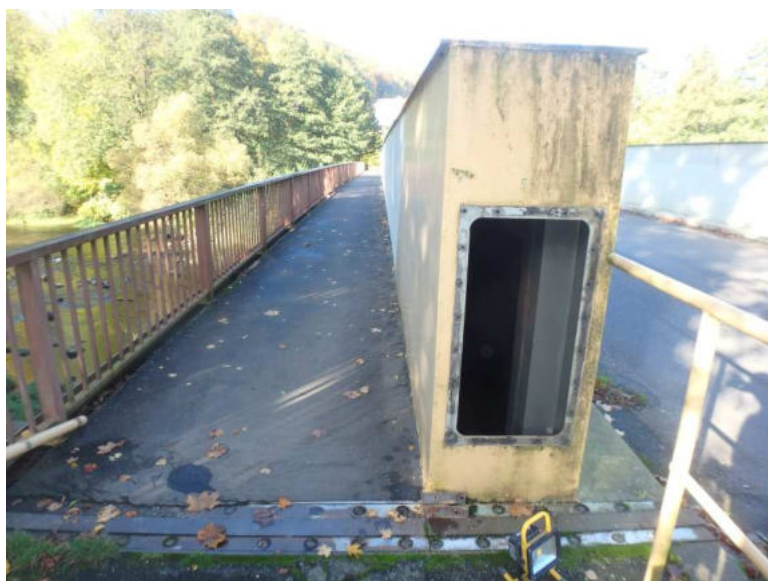
Obr. 3.41 – pravý parapetní nosník v poli 2, pohled na otevřený vstup do nosníku
