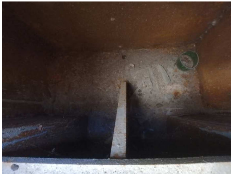
Obr. 3.64 – levý parapetní nosník v poli 1, lokálně poškozená protikorozní ochrana v koncové části nosníku nad pilířem P2, dno, úbytek průřezové plochy do hloubky 1 mm
