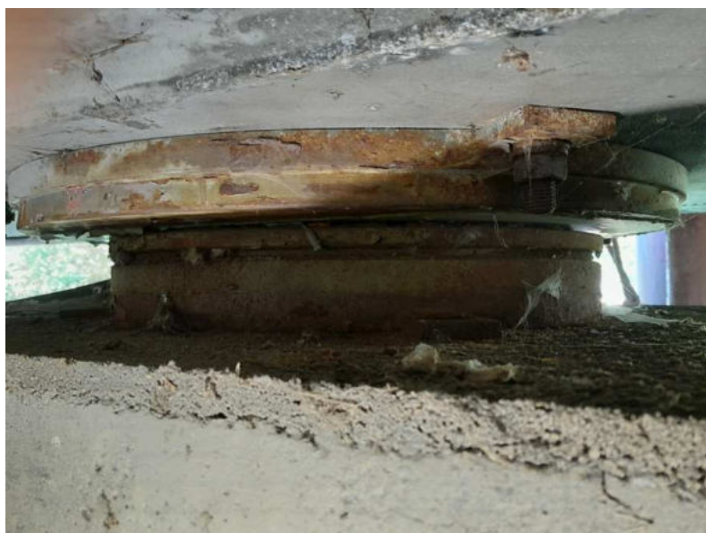
Obr. 3.82 – ložisko Pi2-L-1, plošná povrchová koroze ložiska
