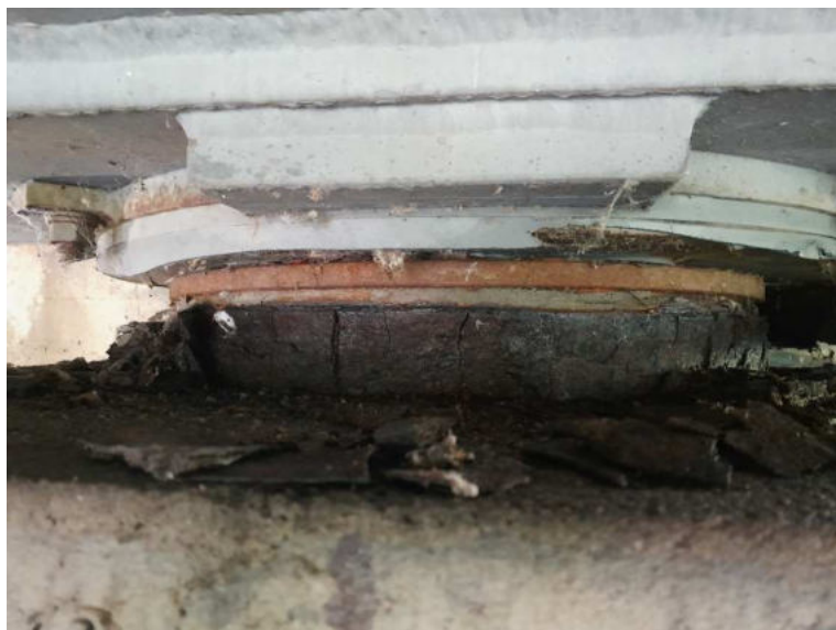
Obr. 3.79 – ložisko OP1-L, velmi silná koroze hrnce ložiska, významné oslabení tělesa hrnce
