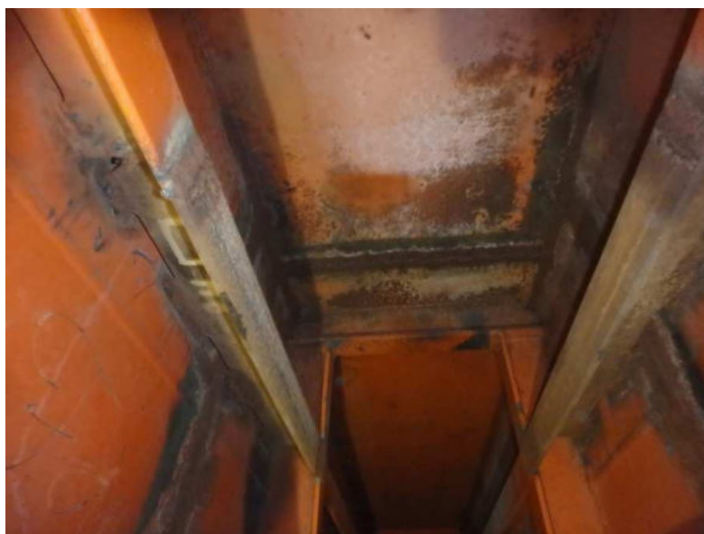
Obr. 3.70 – levý parapetní nosník v poli 2, lokálně poškozená protikorozní ochrana ve stěně nosníku v místě montážního spoje
