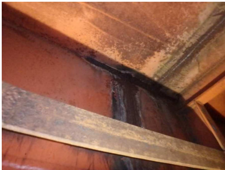
Obr. 3.69 – levý parapetní nosník v poli 2, lokálně poškozená protikorozní ochrana ve stěně nosníku v místě montážního spoje
