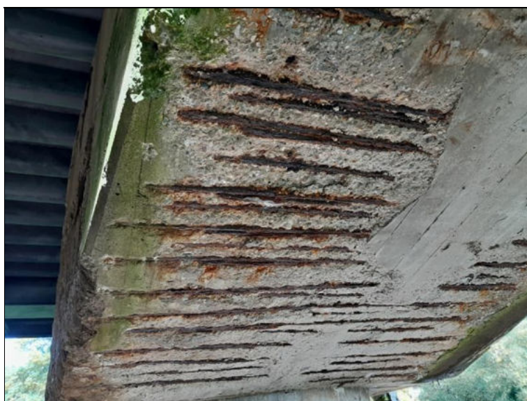
Pilíř P2, spodní líc na pravé straně. Silná koroze betonářské výztuže.
