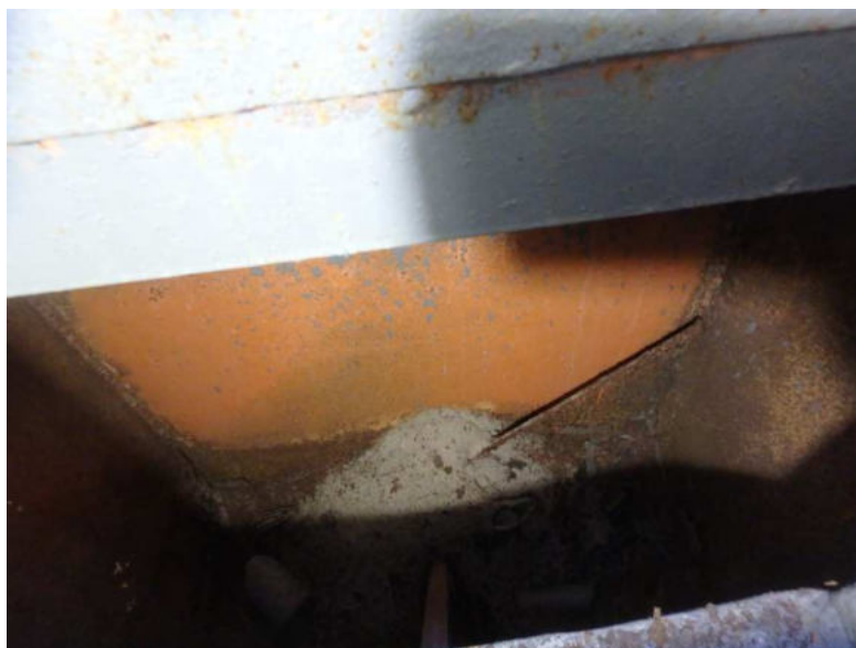
Obr. 3.47 – pravý parapetní nosník v poli 2, plošná povrchová koroze u dna nosníků v koncové oblasti nad pilířem P2, úbytek průřezové plochy do hloubky 1 mm, množství nečistot
