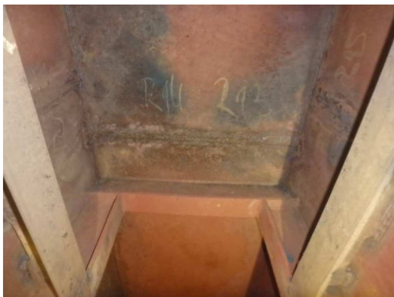
Obr. 3.61 – levý parapetní nosník v poli 1, lokálně poškozená protikoroze ochrana v místě montážního svaru, strop
