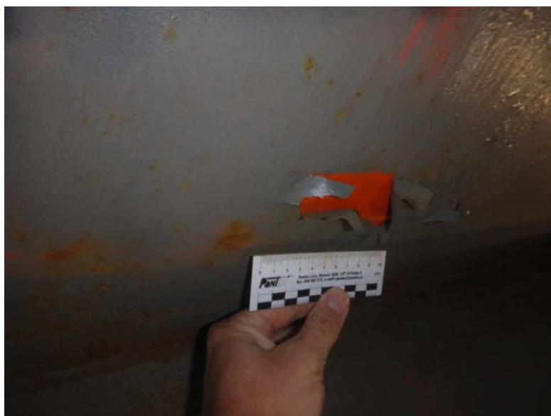
Obr. 3.43 – pravý parapetní nosník v poli 2, poškozená protikoroze ochrana
