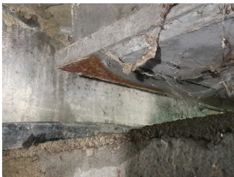
Obr. 3.37 – lokální povrchová koroze nosné konstrukce na spodním líci u opěry OP1
