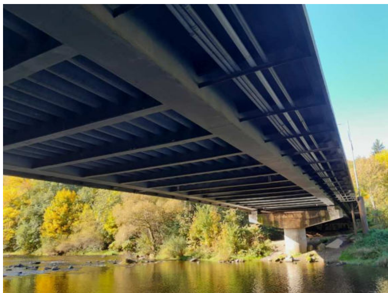
Obr. 3.33 – spodní líc ortotropní mostovky v poli 2
