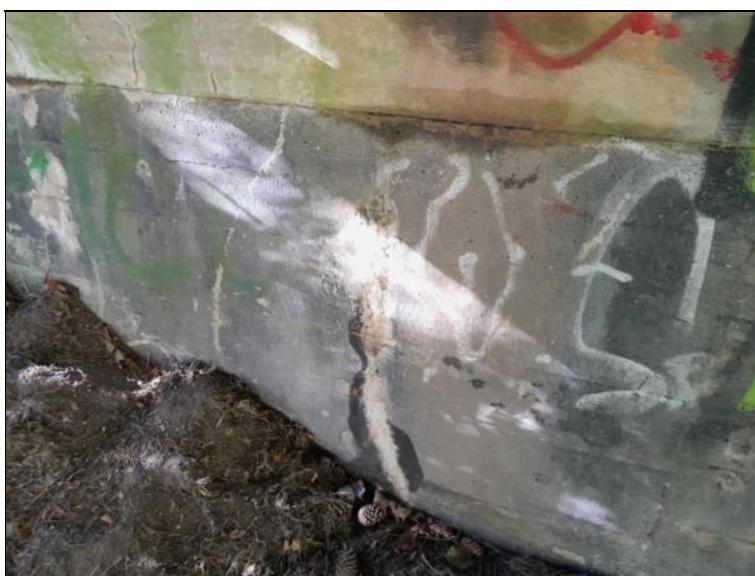
Pata opěry OP1, pravá strana, svislé trhliny s výluhy.
