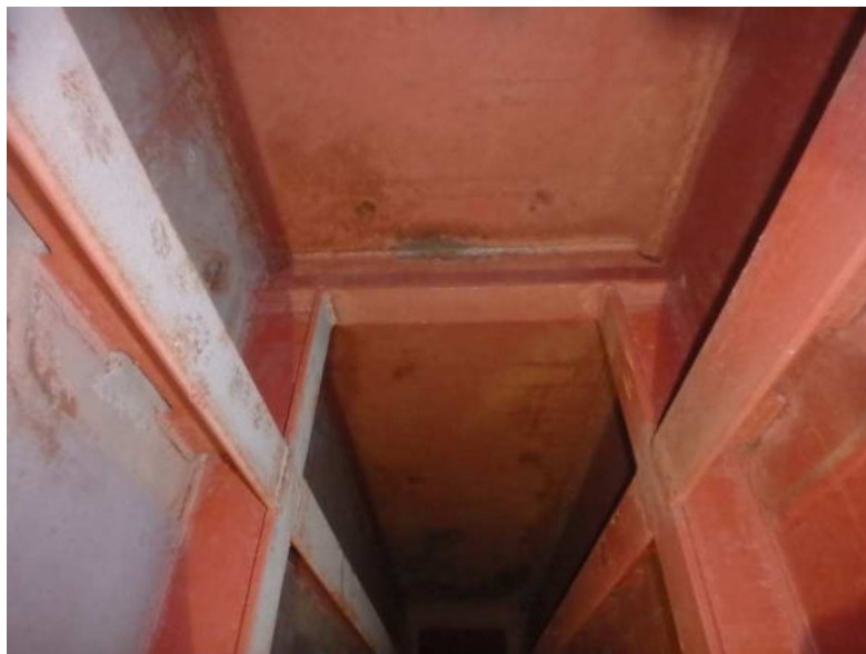
Obr. 3.60 – levý parapetní nosník v poli 1, běžný stav protikoroze ochrany uvnitř komory parapetního nosníku
