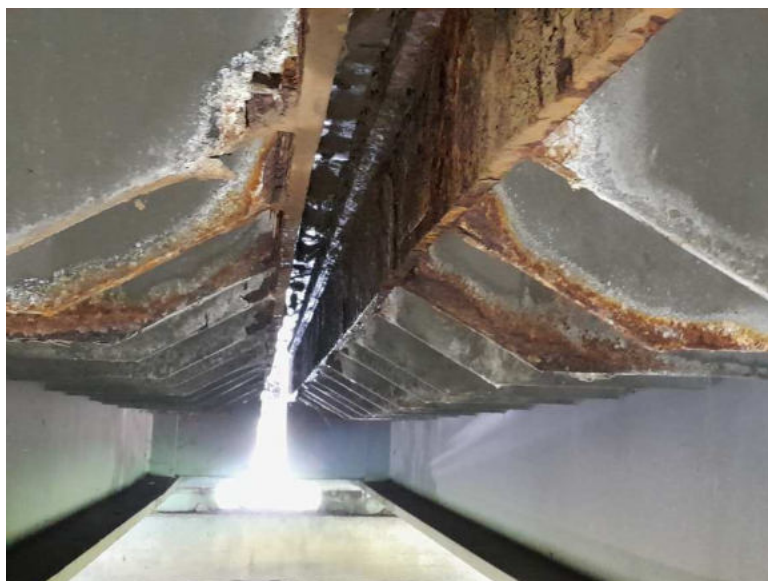
Obr. 3.39 – povrchová koroze koncového příčnicku a podélných výztuh mostovky nad pilířem P2
