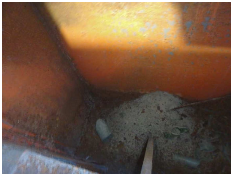
Obr. 3.48 – pravý parapetní nosník v poli 2, plošná povrchová koroze u dna nosníků v koncové oblasti nad pilířem P2, úbytek průřezové plochy do hloubky 1 mm, množství nečistot, detail
