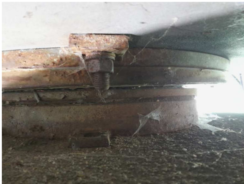
Obr. 3.83 – ložisko Pi2-L-1, plošná povrchová koroze ložiska
