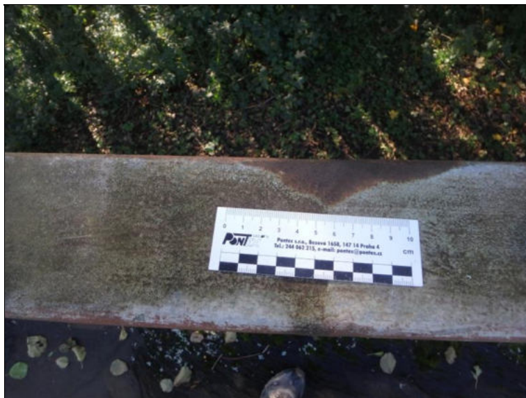
Povrchová koroze zábradlí.
