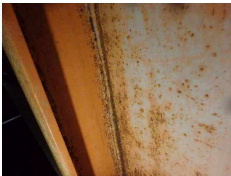
Obr. 3.68 – levý parapetní nosník v poli 2, lokálně poškozená protikorozní ochrana ve stěně nosníku
