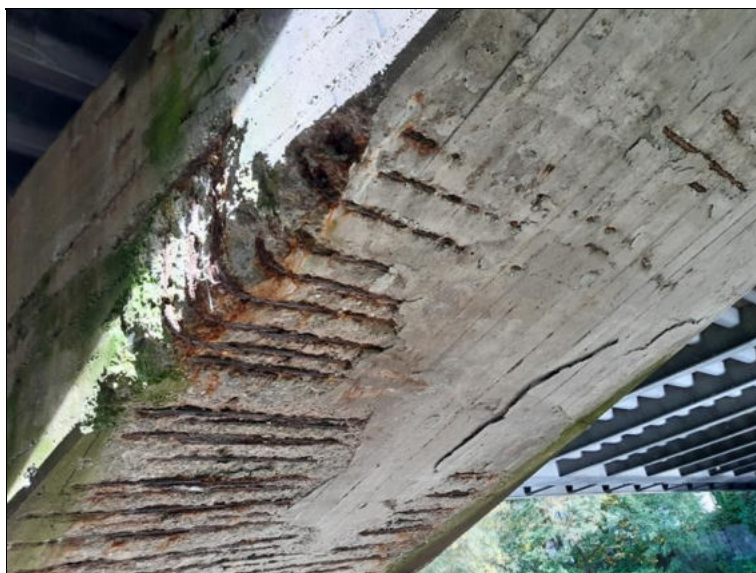
Pilíř P2, spodní líc na pravé straně. Silná koroze betonářské výztuže.
