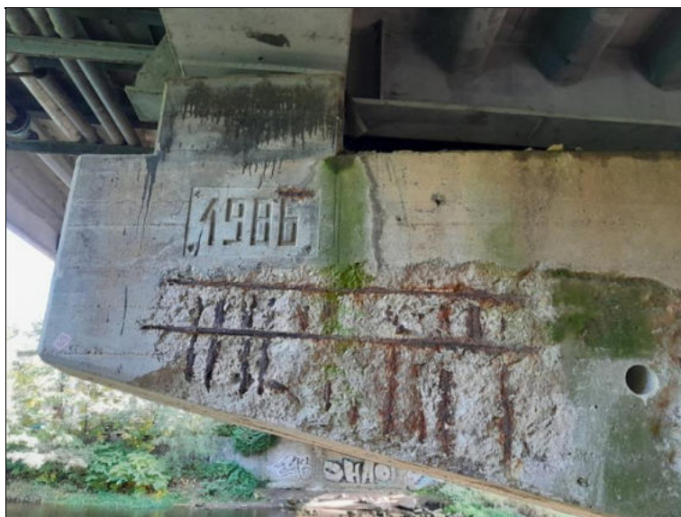
Pilíř P2, pohled do pole 1, plošná koroze betonářské výztuže, pod levým ložiskem.
