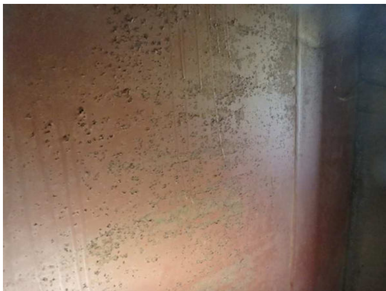
Obr. 3.54 – pravý parapetní nosník v poli 1, lokálně poškozená protikoroze v koncové části nosníku
