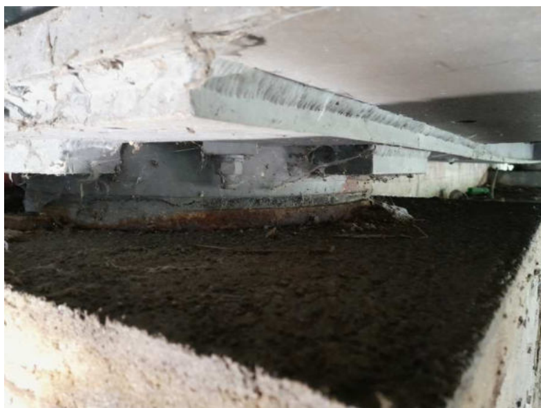
Obr. 3.81 – ložisko OP1-P, povrchová koroze hrnce ložiska
