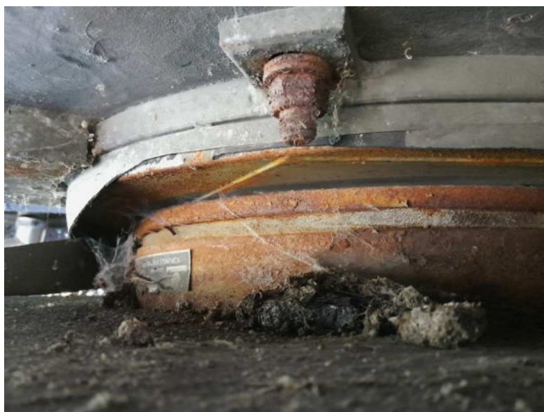
Obr. 3.91 – ložisko OP3-P, plošná koroze hrnce i horní desky ložiska, silná koroze horního kotevního šroubu
