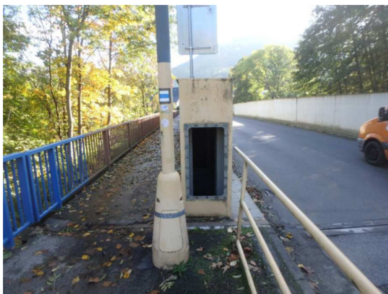
Obr. 3.56 – levý parapetní nosník v poli 1, vstupní otvor nad opěrou OP1
