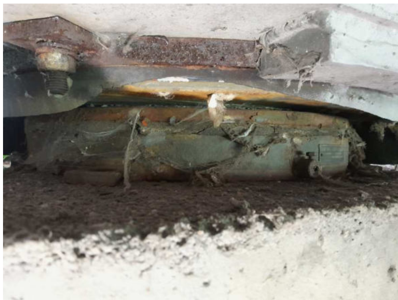
Obr. 3.85 – ložisko Pi2-P-1, lokální koroze ložiska, zejména pak horní desky ložiska, množství nečistot
