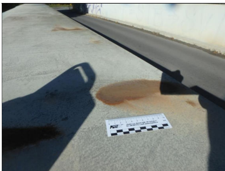
Lokální povrchová koroze na horním líci pravého ocelového parapetního nosníku, pole 1, pravá strana.
