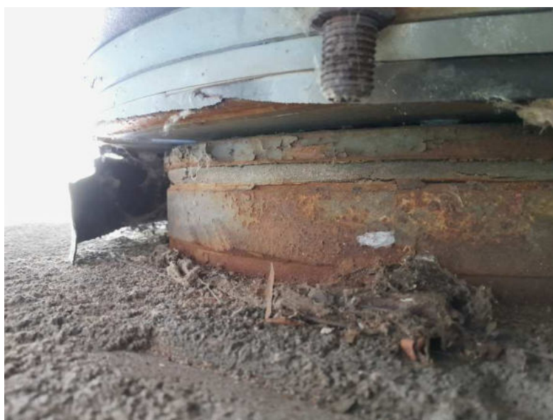
Obr. 3.88 – ložisko Pi2-P-2, plošná koroze ložiska, koroze zjištěna i u horní kluzné desky ložiska
