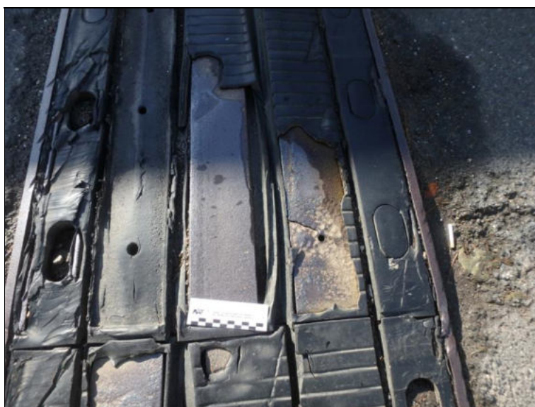
Detail poškozeného mostního závěru nad pilířem P2.
