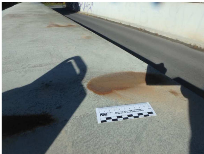
Obr. 3.76 – pravý parapetní nosník v poli 1, lokální poruchy protikorozní ochrany na horním líci nosníku v části nad pilířem P2, povrchová koroze
