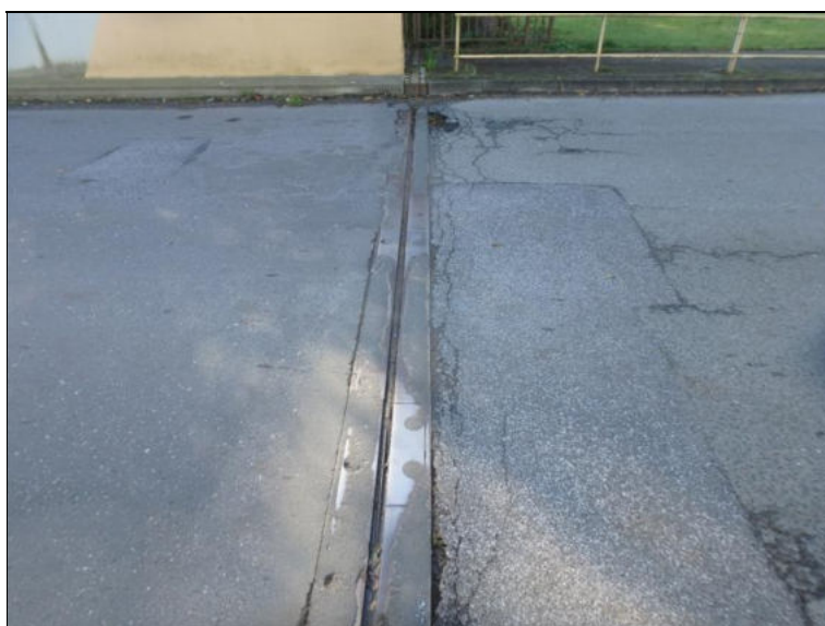
Mostní závěr nad opěrou OP1, u mostního závěru poruchy vozovky.
