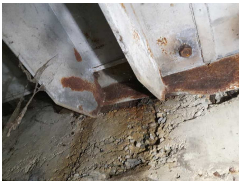
Obr. 3.31 – povrchová koroze koncového příčnicku mostovky nad opěrou OP3
