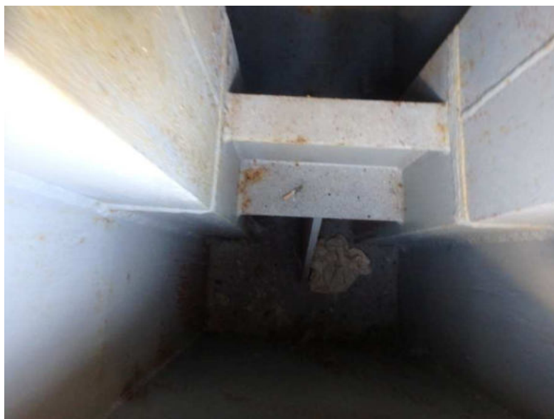
Obr. 3.57 – levý parapetní nosník v poli 1, lokálně poškozená protikoroze v koncové části nosníku nad opěrou OP1, dno, drobné nečistoty
