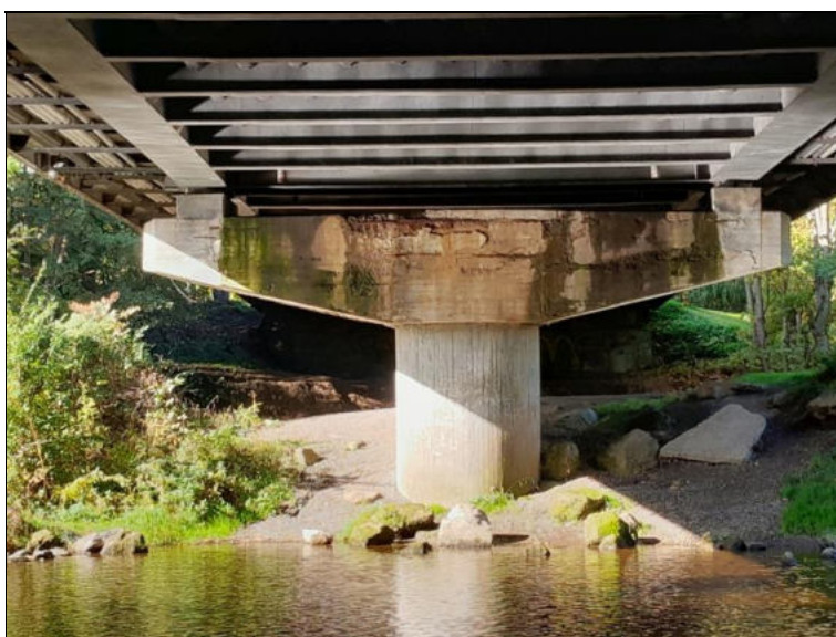
Pilíř P2, silné zatékání.
