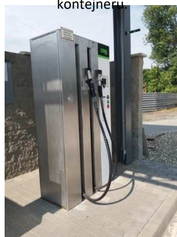
Obrázek č. 12 Výdejní stojan CNG.
