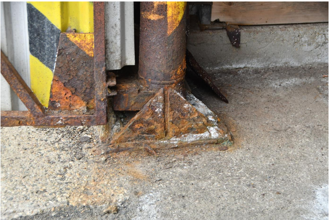
Koroze sloupů u vrat.
