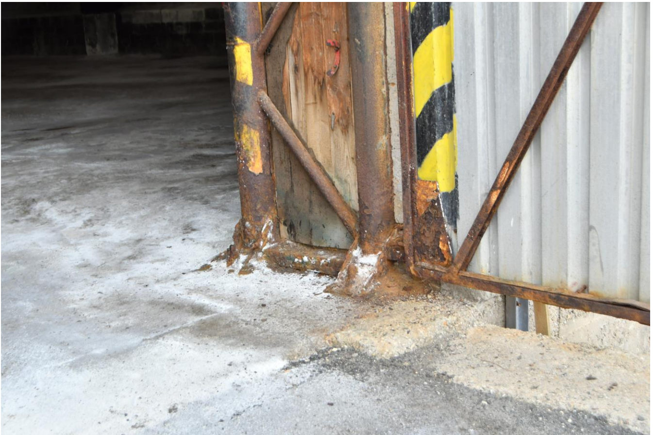
Koroze sloupů u vrat.
