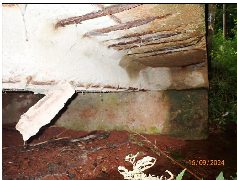
L bok mostu, pohled směrem k opěře O1, poruchy betonu a výztuže na podhledu L konzoly mostovky a trámu 1L.
