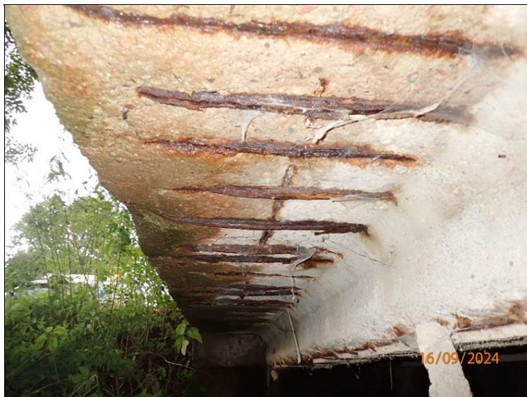
Detail rozsáhlé koroze výztuže na podhledu L konzoly mostovky.
