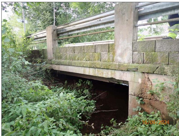
P bok mostu z koryta potoka, zvýšená římsa.
