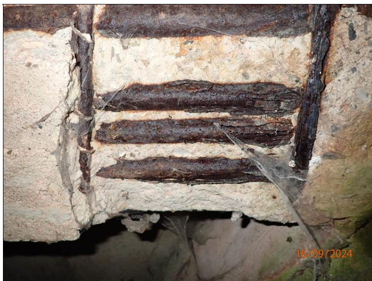
Detail korodující výztuže na podhledu trámu 1P před lícem opěry O2.
