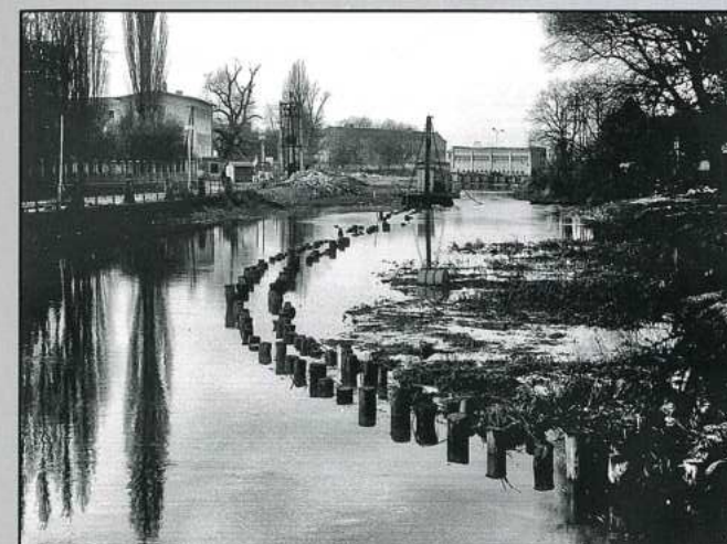
Při zužování toku byla hranice zasypaní zpevněna zaraženými kůly
