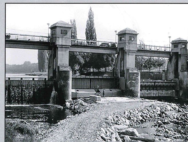
Výměna prostředního stavidla v roce 1986, vlevo je ještě stavidlo původní
