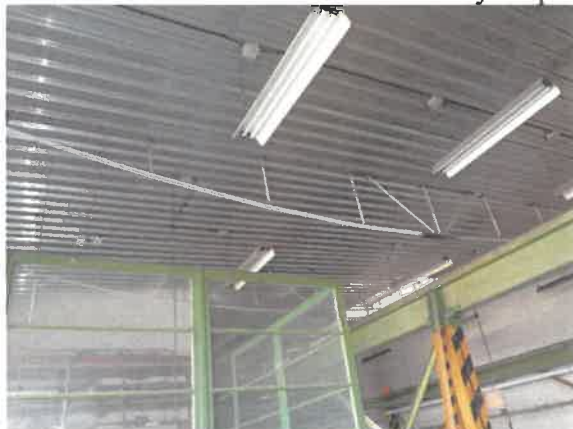
Foto č. 9 až 12 – Sonda ST2 – Pohledy zespod na podhled a příhradové vazníky
