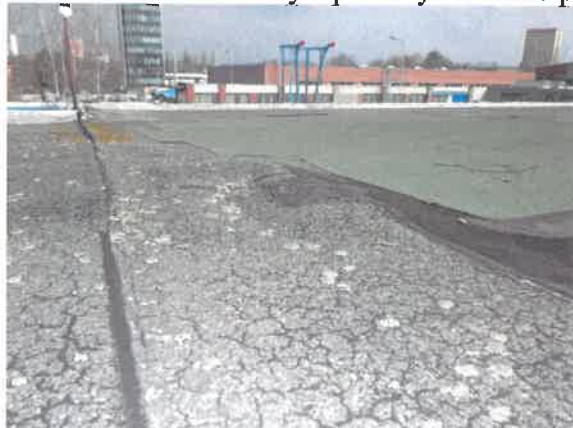
Foto č. 33 až 40 – Vady a poruchy střešního pláště
