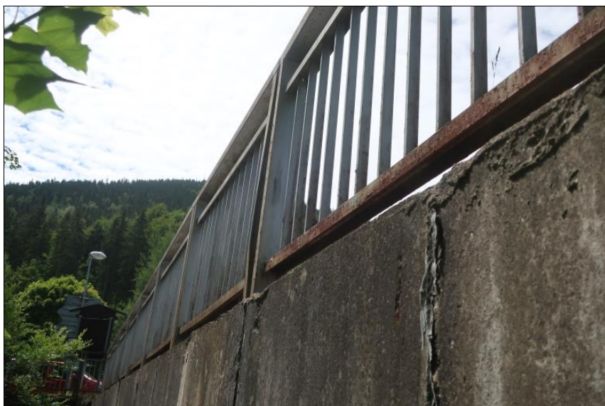
koroze zábradlí
