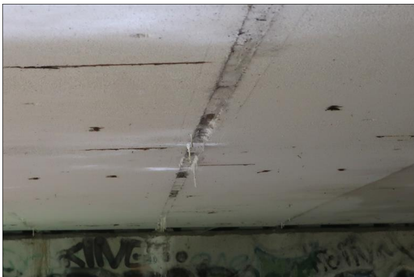
koroze konstrukční výztuže na spodním líci nosníků
