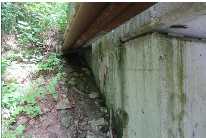
stopy po průsacích na lici pravého křídla O1
