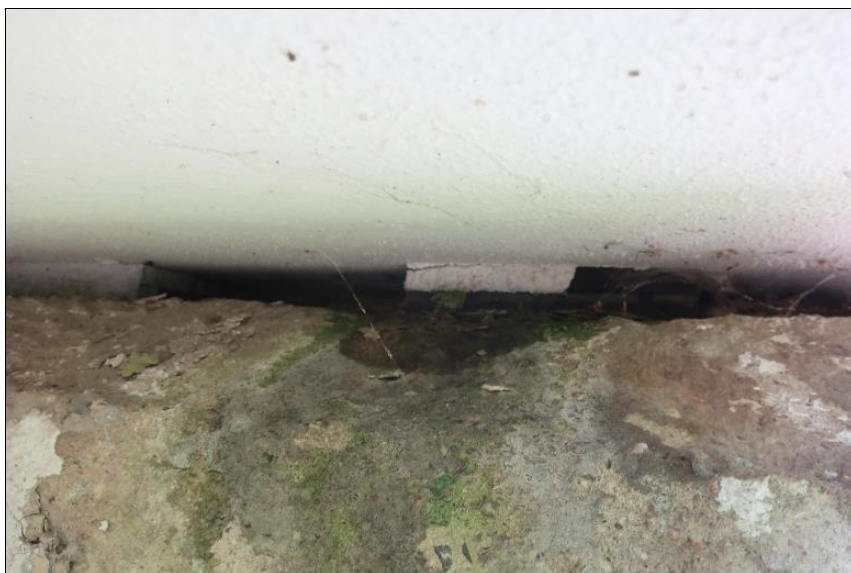
elastomerová ložiska
