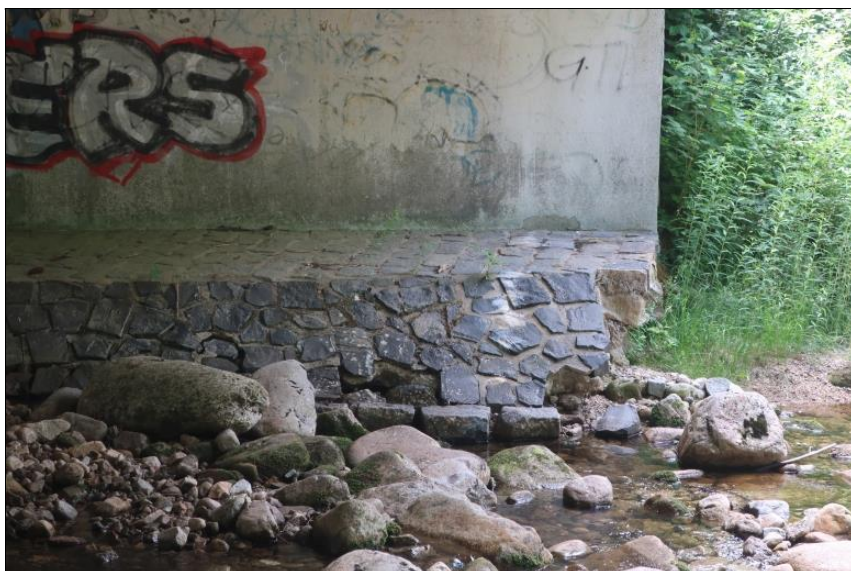
podemleté opevnění břehu Mumlavý u O2
