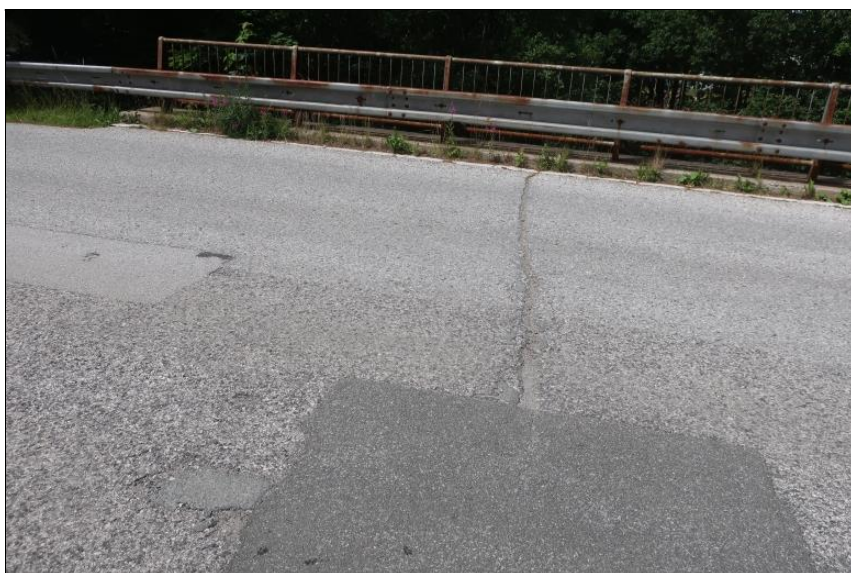
příčná trhlina v krytu vozovky nad O2
