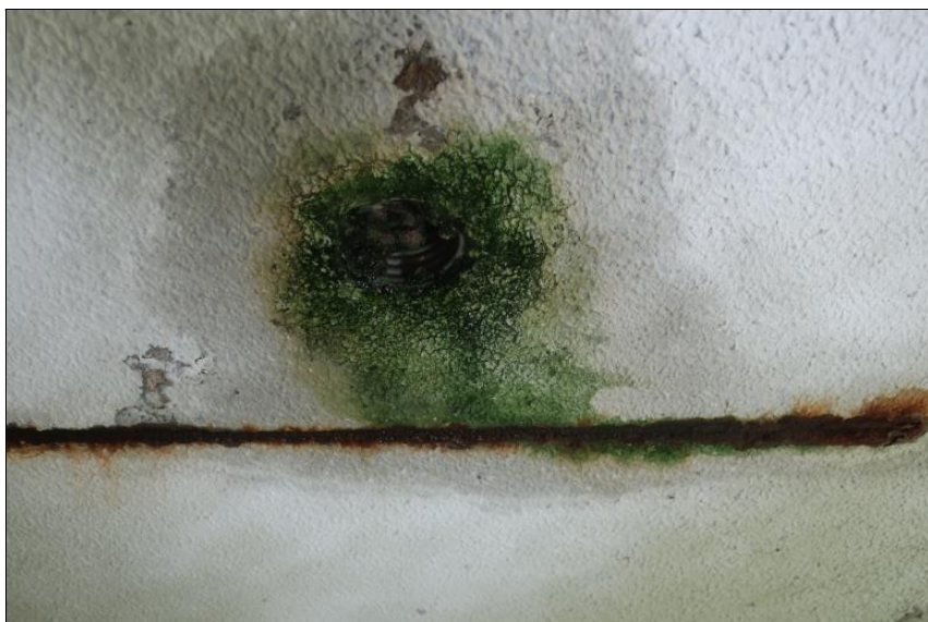
aktivní průsak z dutiny nosníku
