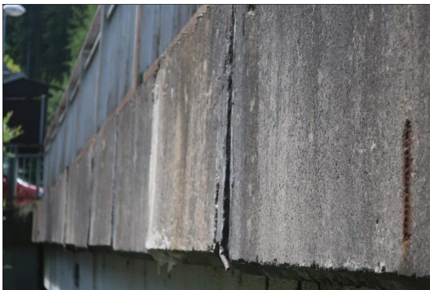
vykloněný římsový prefabrikát
