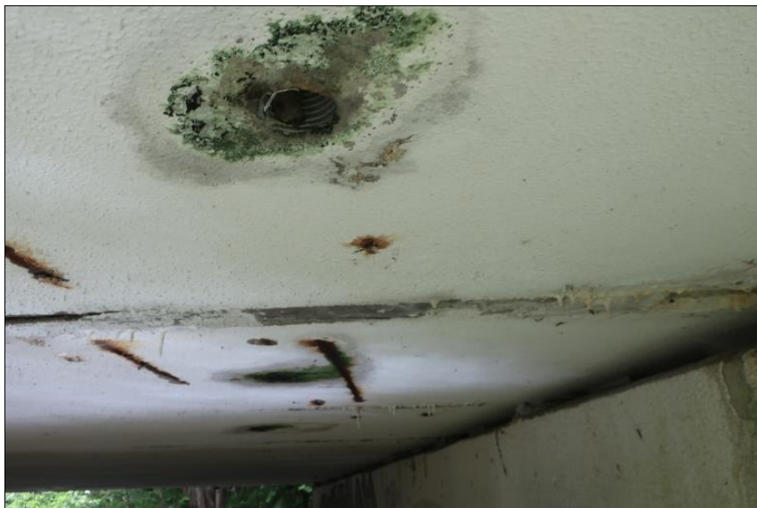
stopy po průsacích z dutin nosníků
