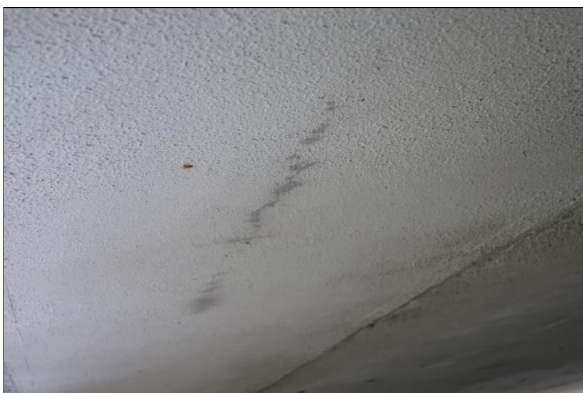
zavhlá podélná trhlina kopírující trajektorii předpínací výztuže
