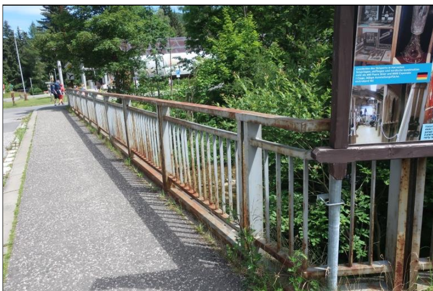
zábradlí levé koroduje
