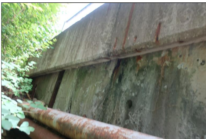
koroze výztuže římsy
