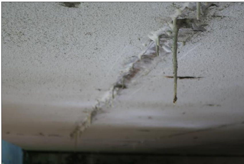
stopy po průsacích s výluhy pojiva na spodním líci NK
