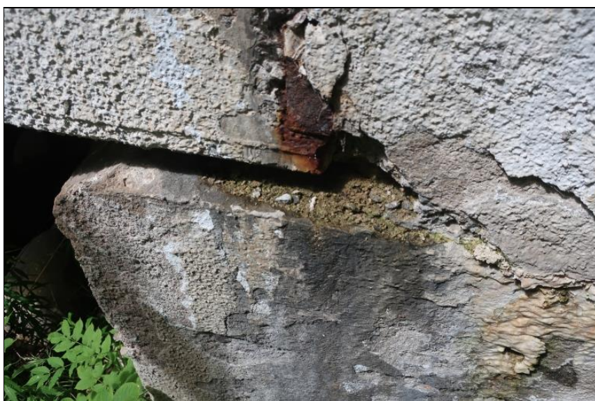
koroze kotvy předpínací výztuže
