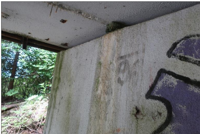
stopy po průsacích s výluhy pojiva na líci O1
