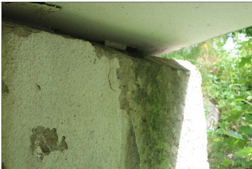
degradace betonu ÚP O1 v místě průsaku
