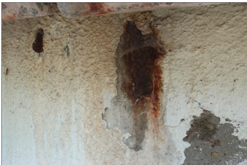
koroze betonářské výztuže na vnějším boku 1. nosníku
