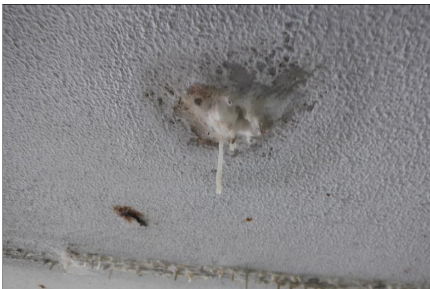
aktivní bodový průsak na spodním líci nosníku
