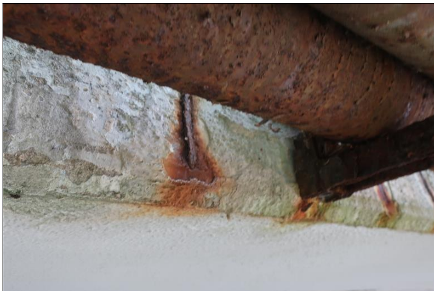
koroze konstrukční výztuže na vnějším boku pravého krajního (10.) nosníku
