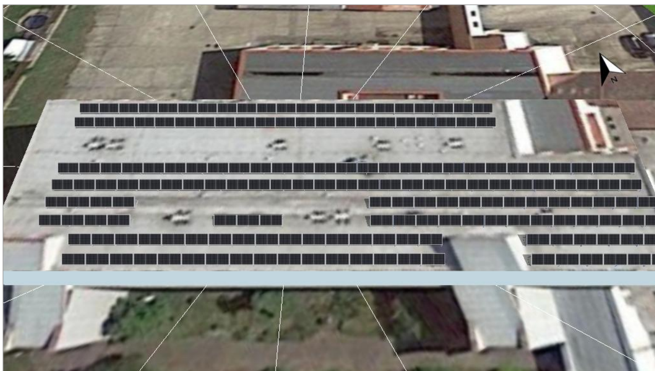
Obrázek: 1. Umístění modulu - Budovy 01-Plocha střechy Jihozápad
