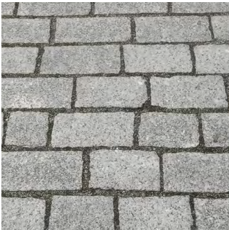
žulová dlažba se spárou uzpůsobenou vsaku vody
