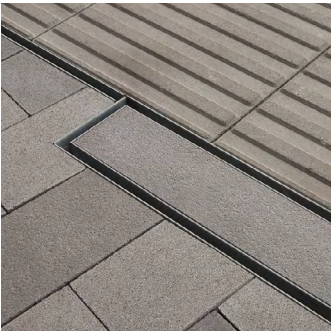
štěrbínový žlab a odvod vody do retenční nádrže
