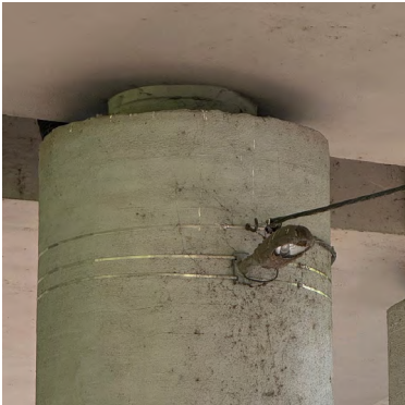
MÉNĚ VHODNÁ VARIANTA svítidla zavěšená na objímkách, nutné prověřit světelný výpočet, než se zvolí tato varianta
