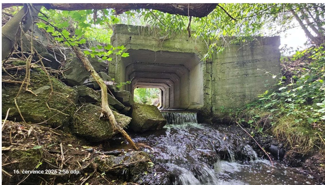
MK č. 25c propustek – výtok
