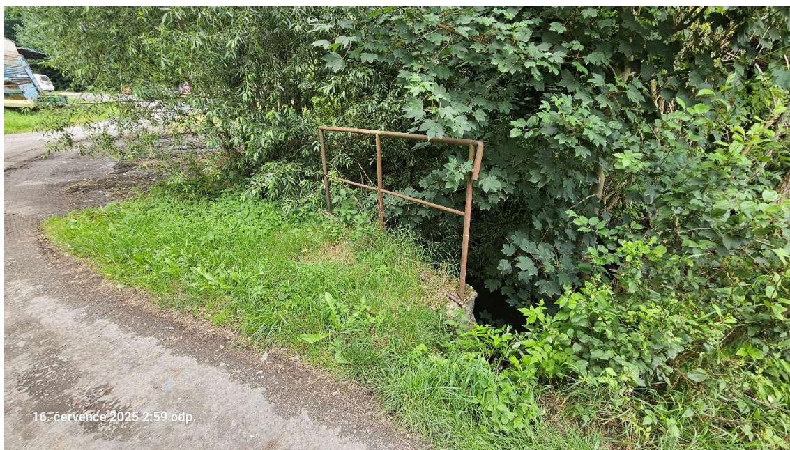
MK č. 25c propustek – výtok
