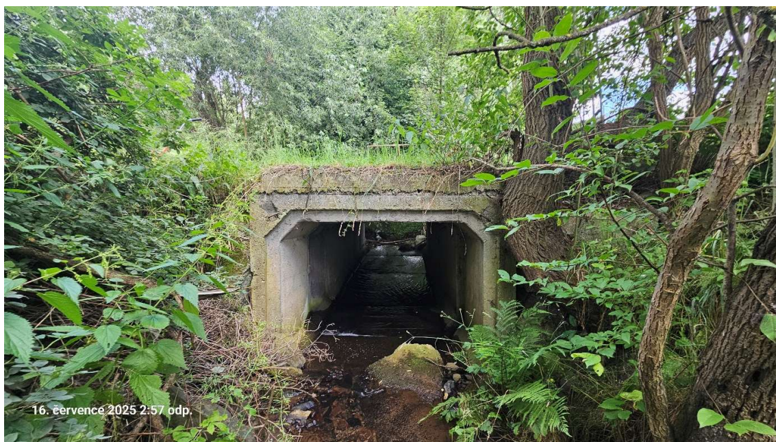
MK č. 25c propustek – vtok
