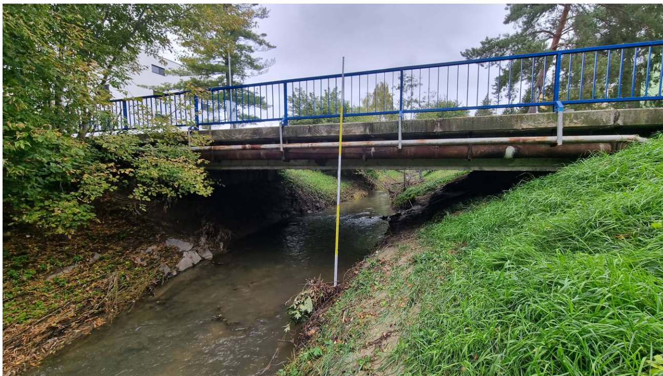
Obr. DSC_0998 ↑, celkový pohled na most ev. č. M09-MK
