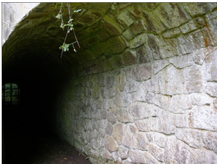
zatékání na pravé straně NK
