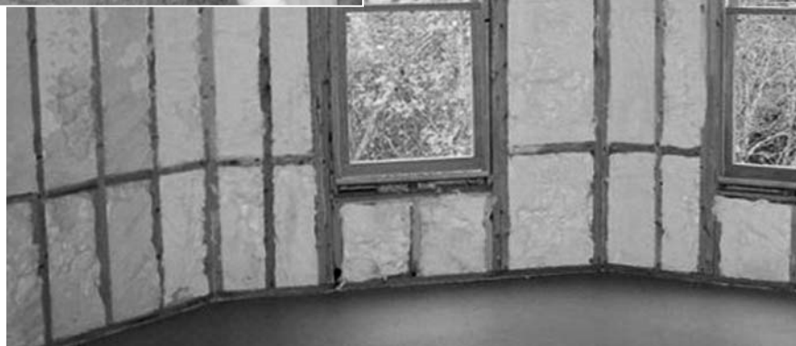
Netěsnosti klasické izolace, které způsobují únik tepla
