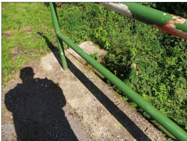
degradace betonu římsy, poškozená PKO
