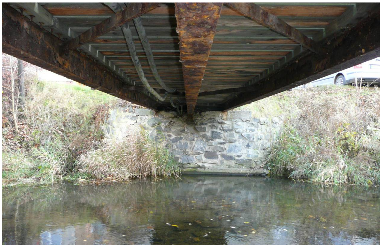
Pohled na opěru OP2 a podhled NK s neznámým kabelovým vedením
