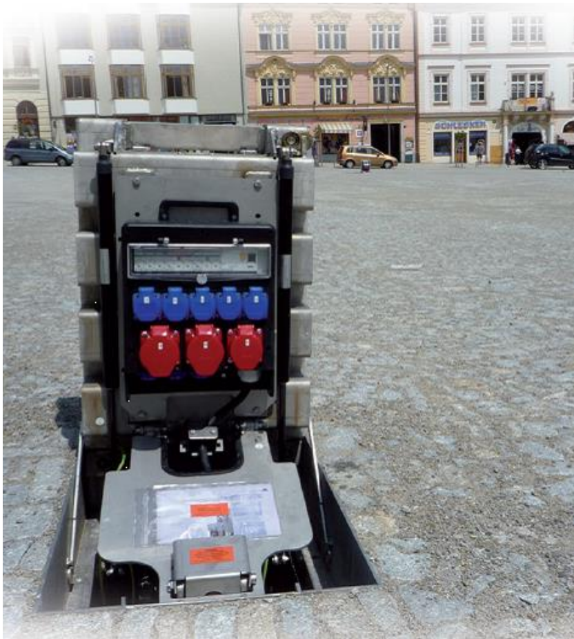
Podzemní rozvadeč připravený k připojení uživatelů
