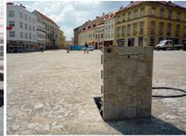
Podzemní rozvadeč připravený k připojení uživatelů
