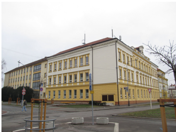
Foto č. 4 - pohled na budovu ze severu
