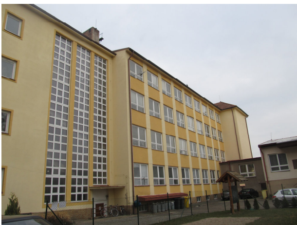
Foto č. 6 - pohled na budovu z jihu
