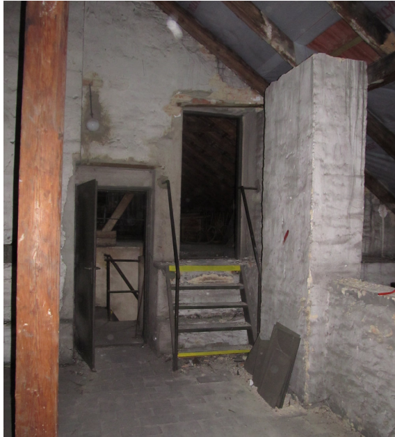
Foto č. 3 – propojení podkrovních prostor „staré“ budovy a „nové“ budovy
