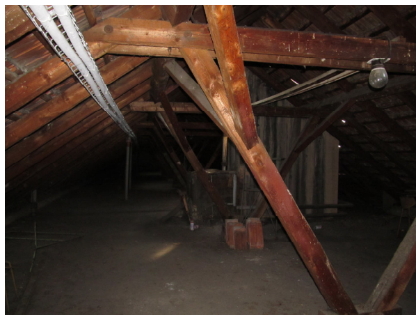
Foto č. 2- Podkrovní prostor „nové“ budovy
