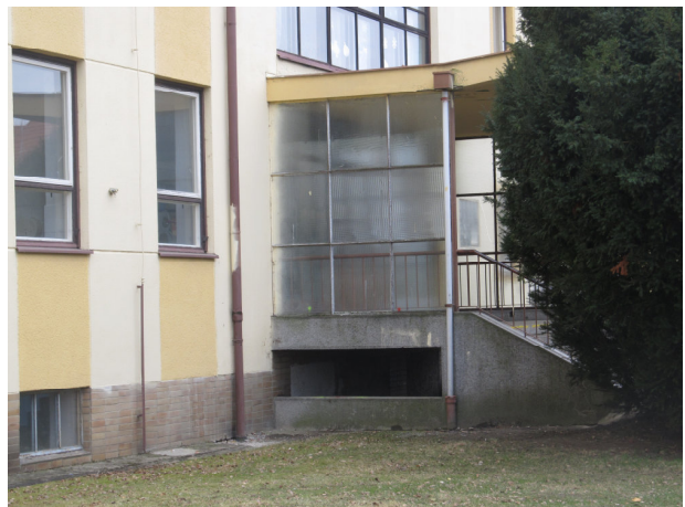
Foto č. 5 - pohled na budovu severu – zastřešení hlavního vstupu
