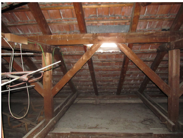
Foto č. 1 – podkrovní prostor „nové“ budovy
