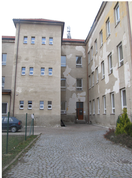
Foto č. 6 - pohled na budovu z východu
