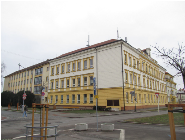
Foto č. 4 - pohled na budovu ze severu
