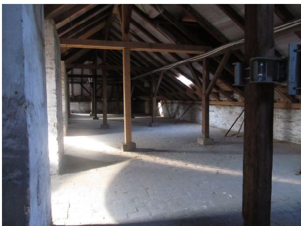
Foto č. 1 – podkrovní prostor „nové“ budova
