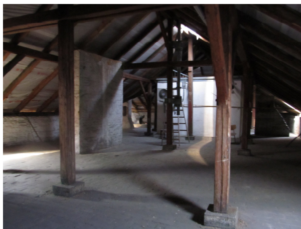
Foto č. 2- Podkrovní prostor „nové“ budovy
