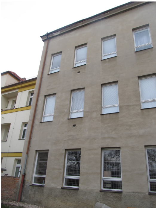
Foto č. 5 - pohled na budovu z východu
